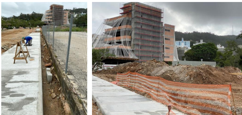
Figura 12 – Bloco Administrativo do CFM – Obra em execução
