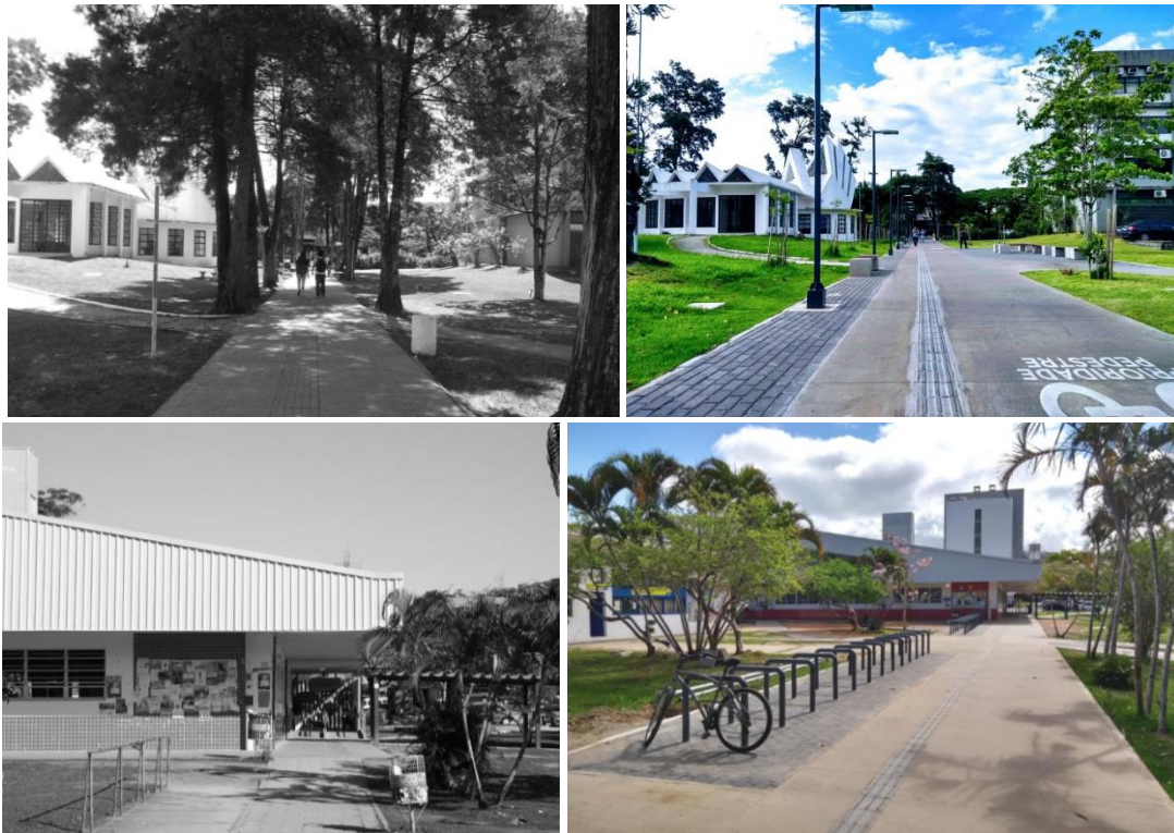
Figura 24 – Projeto Rotas Acessíveis – Piloto Trecho I - Mosaico antes/depois
