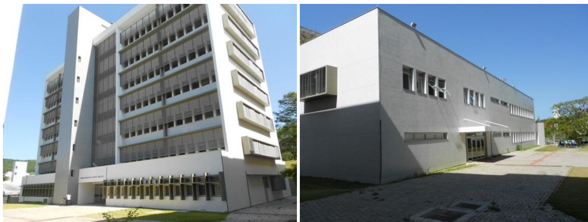
Figura 4 – Bloco E/F e Bloco E Anexo
