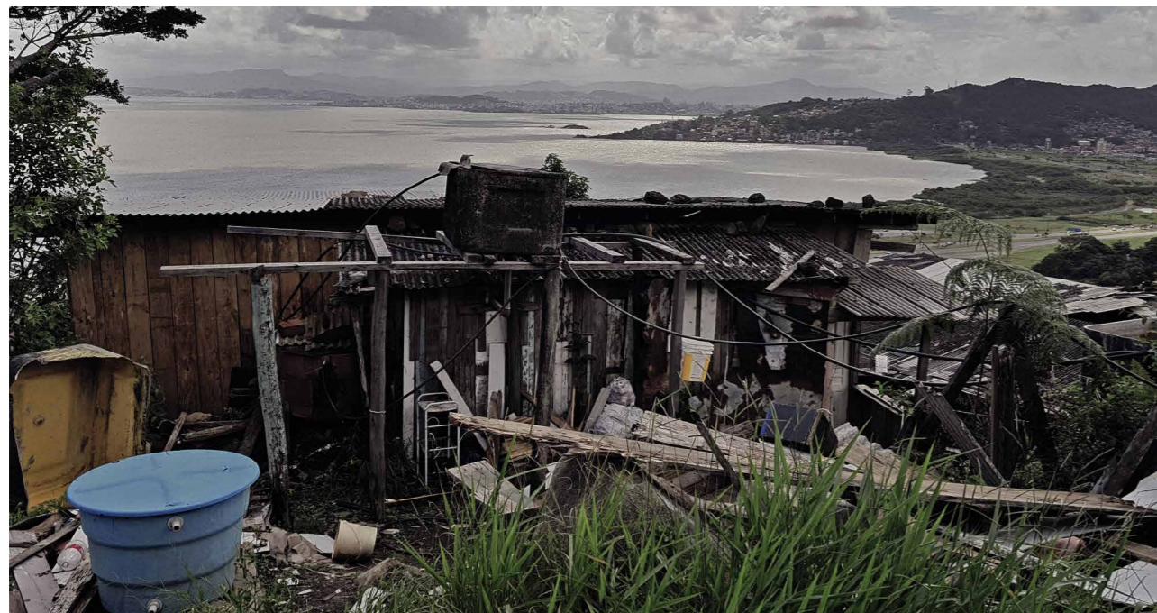
Figura 11 - Situação precária das habitações na Cidade Alta. Foto: Acervo do Autor.
