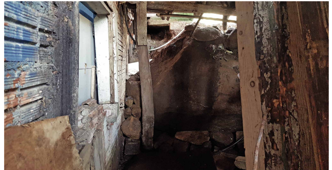
Figura 13 - Pedra cedeu juntamente com o solo durante chuvas. Foto: Acervo do Autor.
