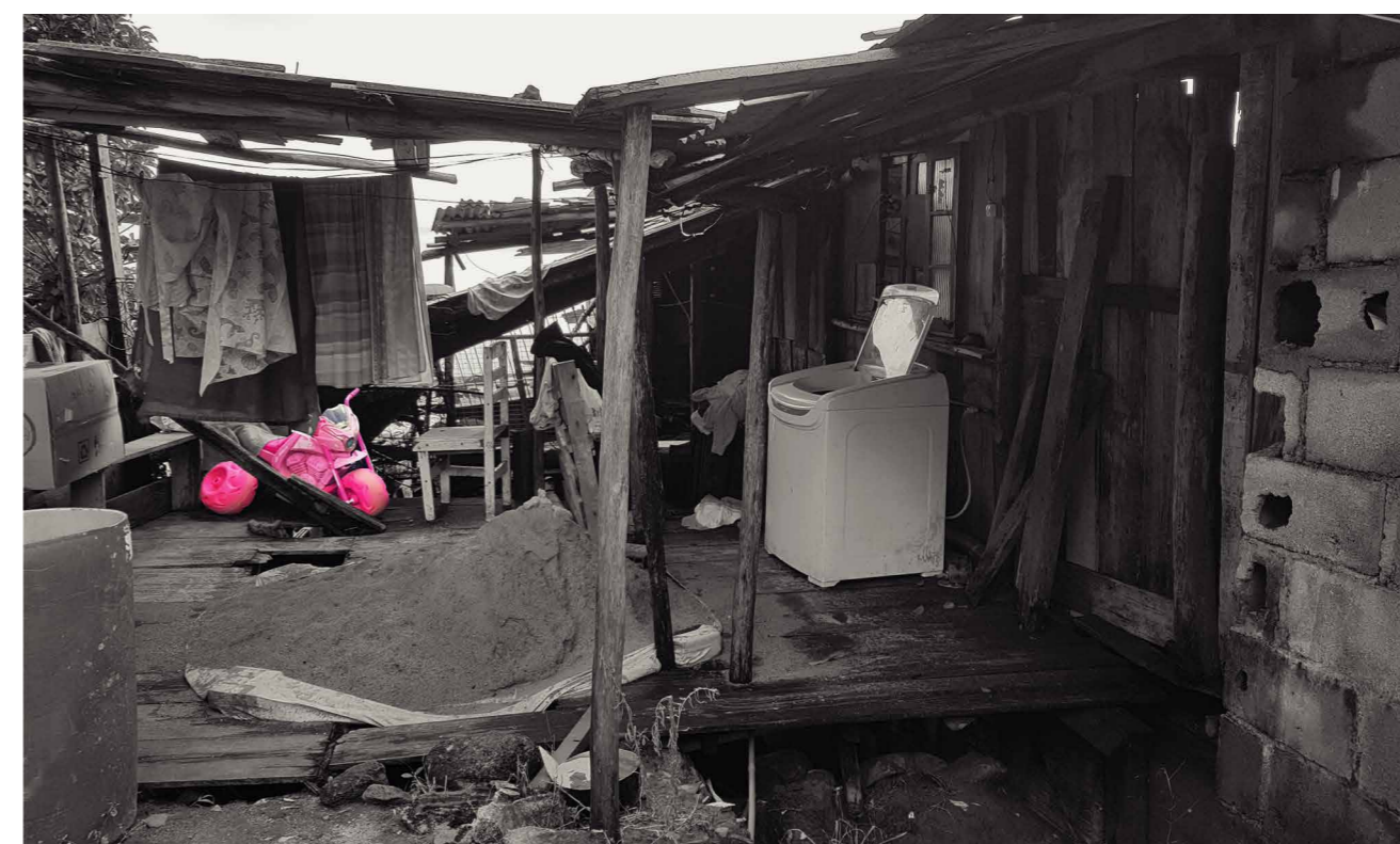
Figura 10 - Situação precária das habitações na Cidade Alta. Foto: Acervo do Autor.
