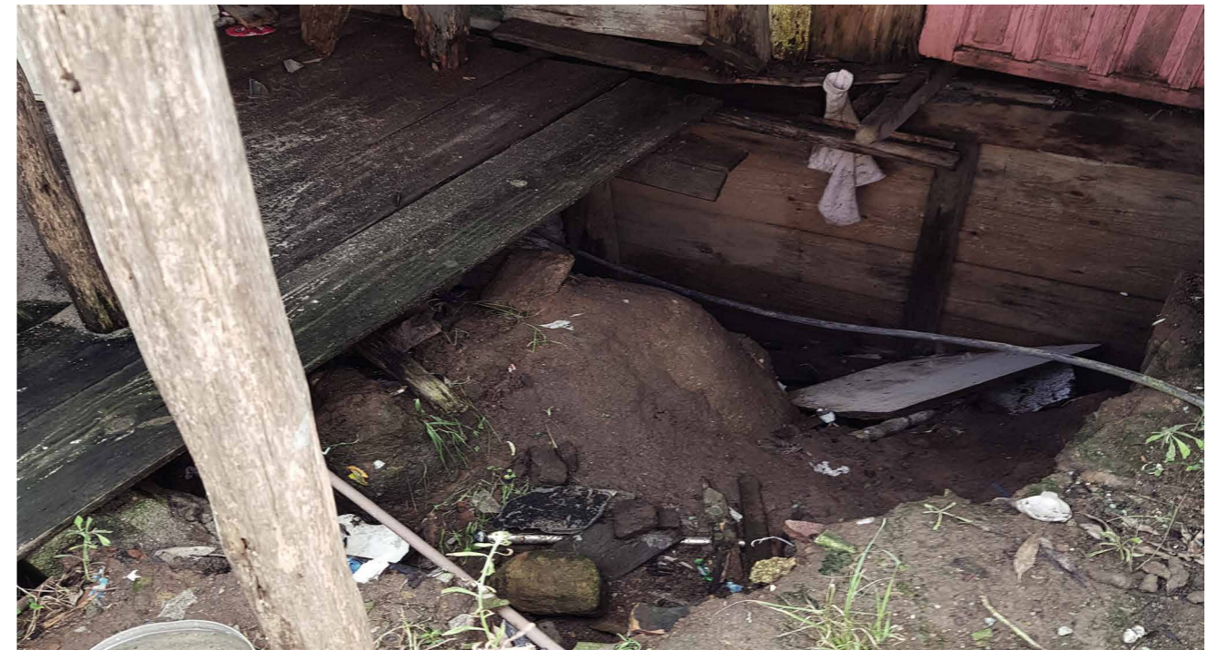
Figura 12 - Parte do solo que cedeu com a chuva. Foto: Acervo do Autor.
