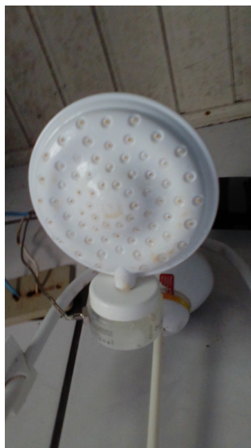
Figura 19 – Instalação do sensor de temperatura de saída.
