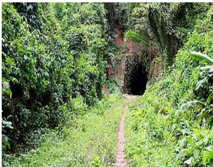
Figura 3.13. Primeiro túnel ferroviário do Brasil
