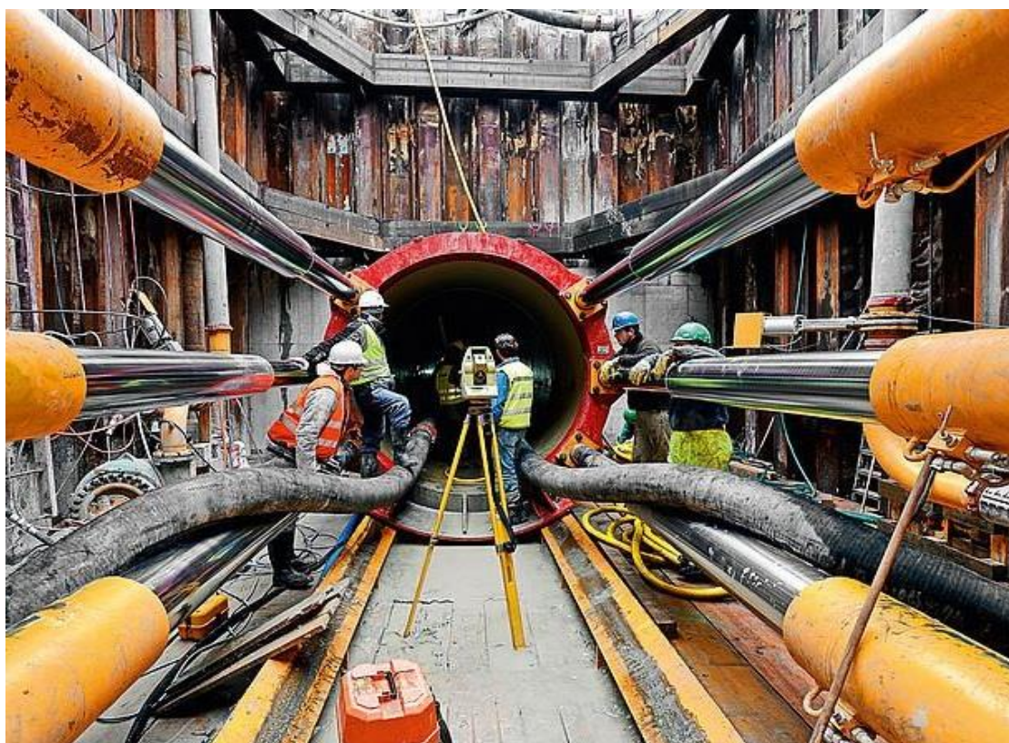
Figura 2.28. Cilindros de avanço do sistema pipe jacking
