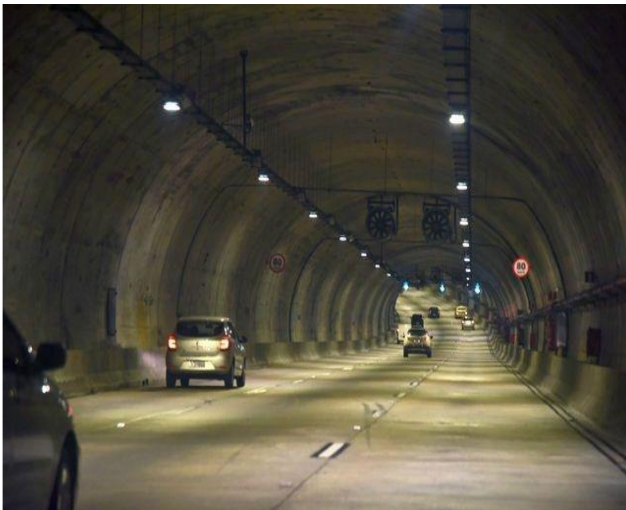
Figura 3.16. Maior túnel rodoviário - Túnel Prefeito Marcello Alencar
