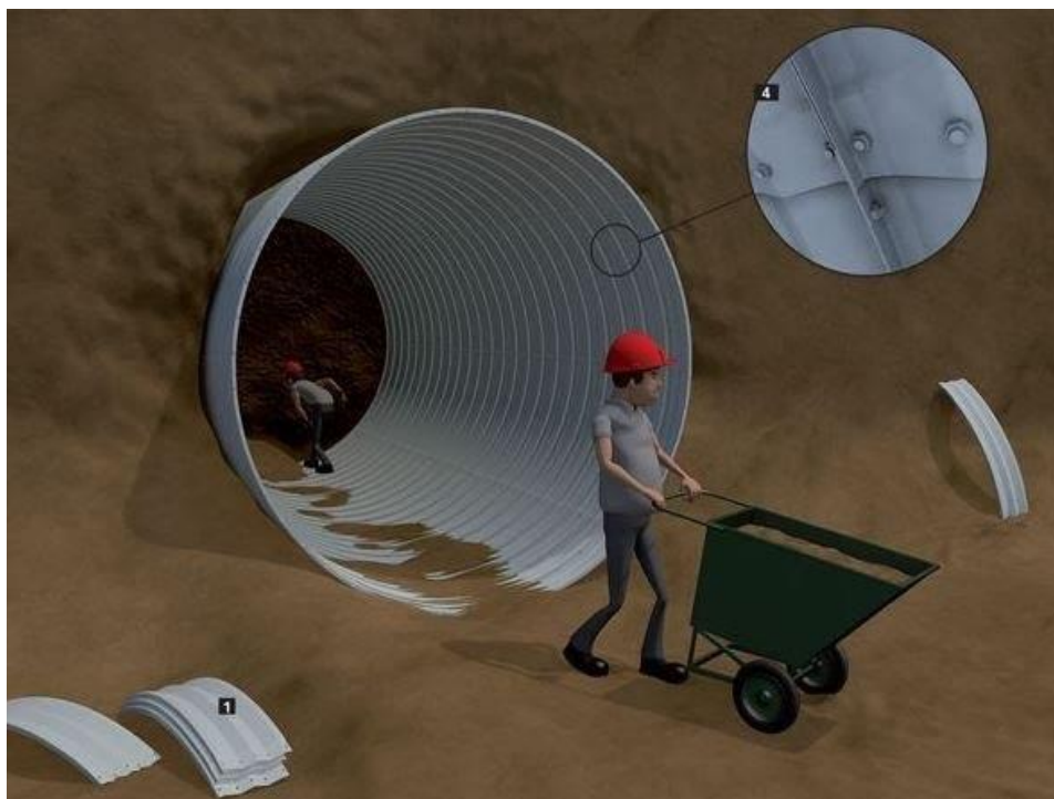
Figura 2.17. Montagem da estrutura de chapa corrugada
