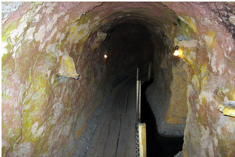
Figura 2.6. Coletor de esgoto
