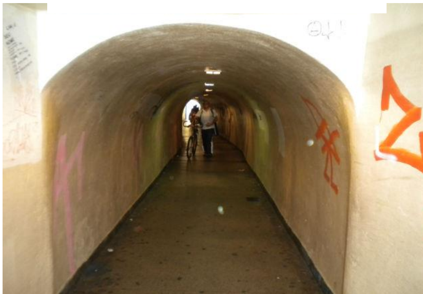
Figura 2.8. Túnel de passagem- “Toca da onça”
