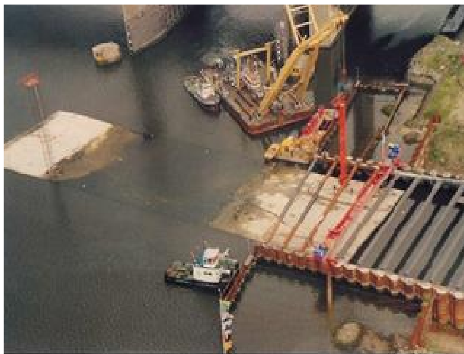
Figura 4.23. Submersão dos elementos
