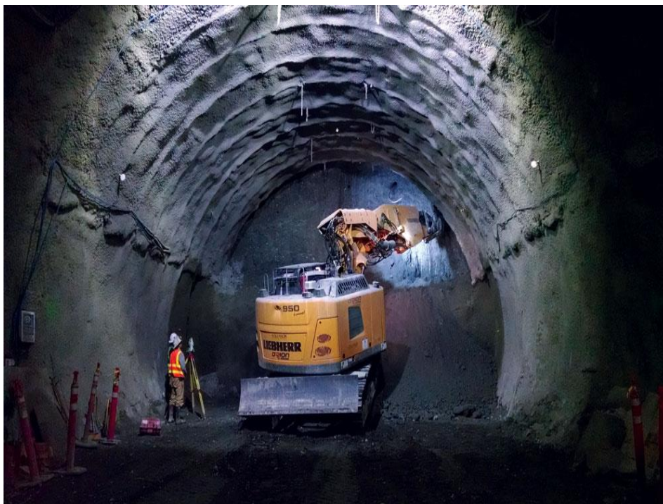
Figura 2.11. Processo construtivo NATM - Túnel Bellevue
