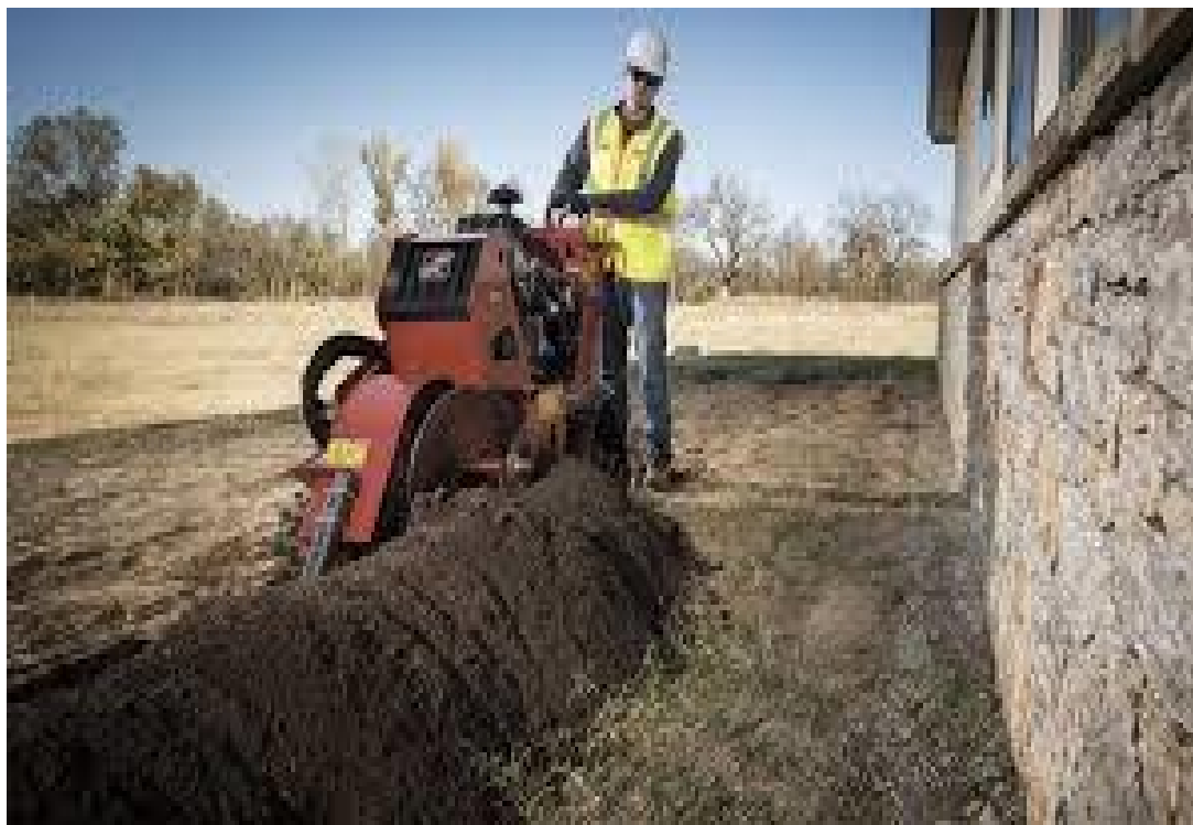
Figura 2.25. Valetadeira sobre esteiras com lança de escavação (pequena dimensão).
