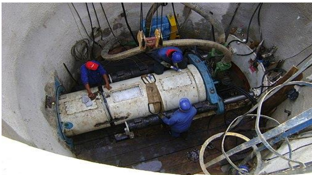
Figura 2.26. Montagem da tuneladora no fundo do poço de entrada.
