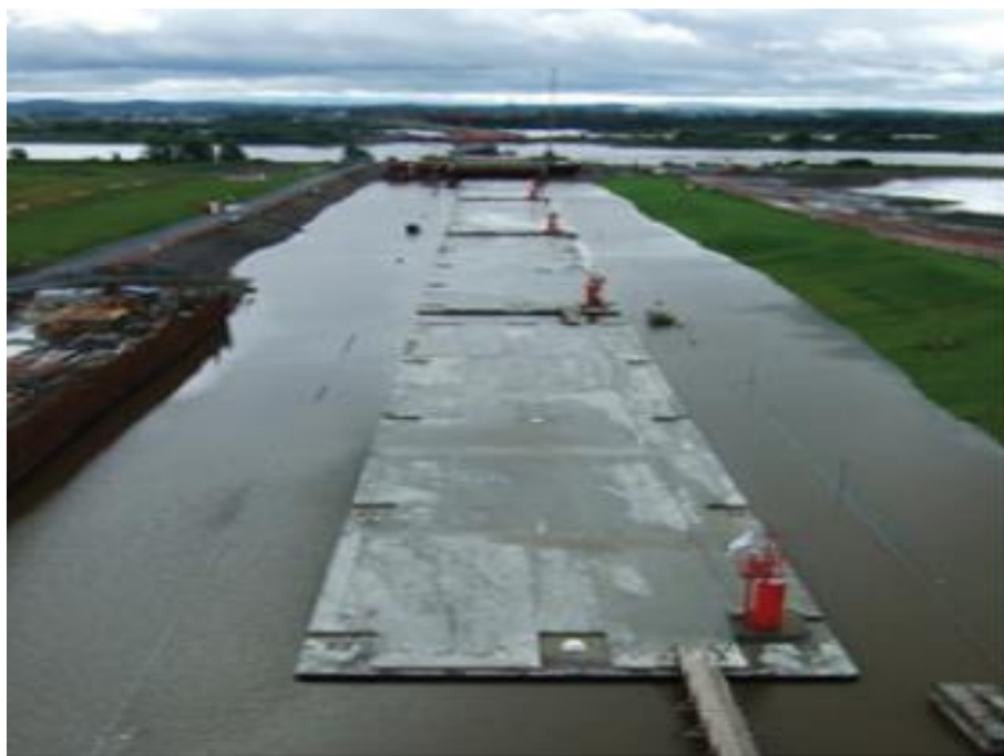
Figura 4.21. Flutuação dos elementos
