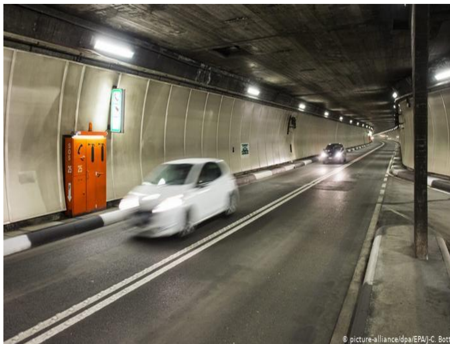
Figura 2.2. Túnel rodoviário (São Bernardino)
