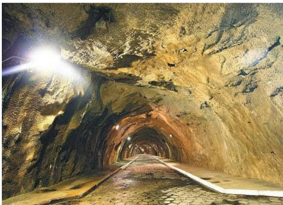
Figura 2.7. Reservatório túnel da Sabesp
