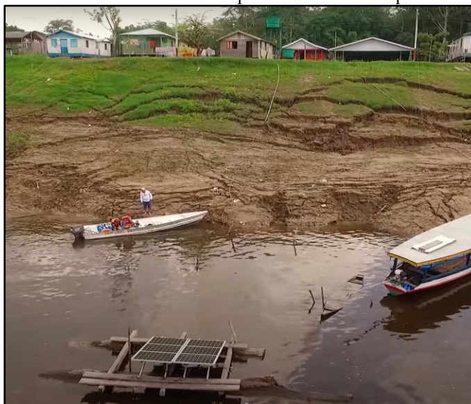
Figura 3 - Sistema de balsas flutuantes e painéis fotovoltaicos para bombear a água.
