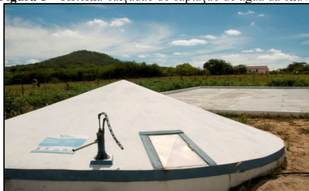
Figura 8 - Cisterna-calçada de captação de água da chuva.
