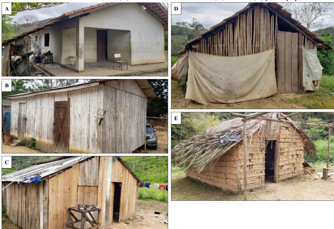
Figura 37 - Fotos das diferentes estruturas das habitações na Aldeia V'ya , Major Gercino/SC: (A) alvenaria; (B) madeira menos vulnerável; (C) madeira mais vulnerável; (D) bambu; (E) pau-a-pique.
