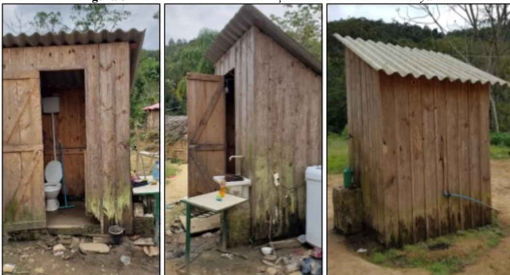
Figura 32 - Fotos mostrando as condições dos MSD da Aldeia V'ya.
