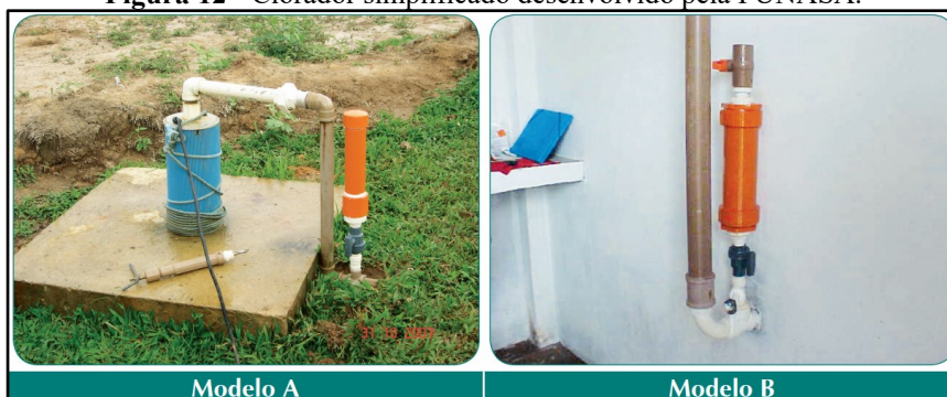
Figura 12 - Clorador simplificado desenvolvido pela FUNASA.
