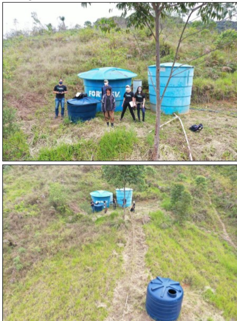
Figura 28 - Fotos de drone dos reservatórios da Aldeia V'ya.
