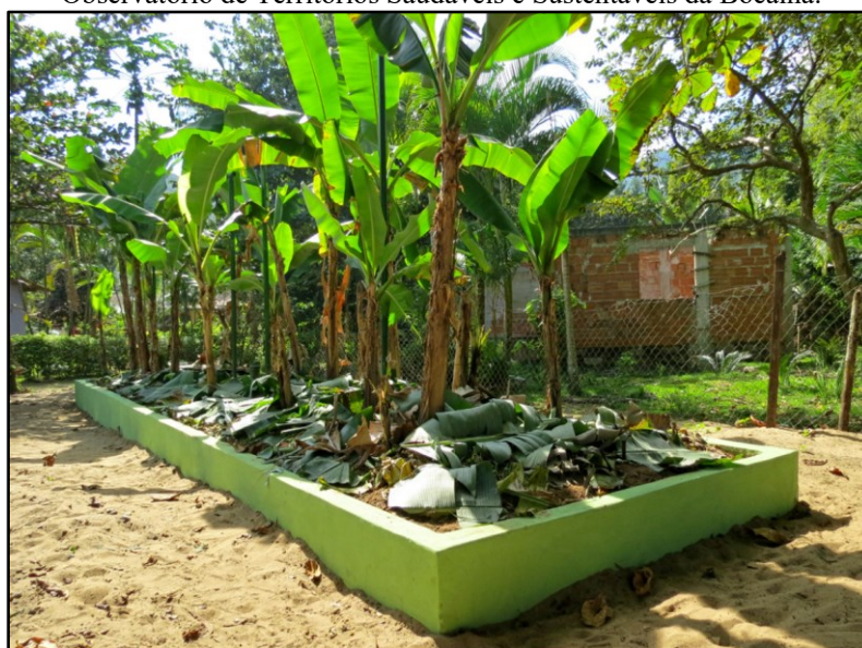
Figura 16 – Bacia de Evapotranspiração construída em comunidade caiçara de Paraty/RJ pelo Projeto Observatório de Territórios Saudáveis e Sustentáveis da Bocaina.
