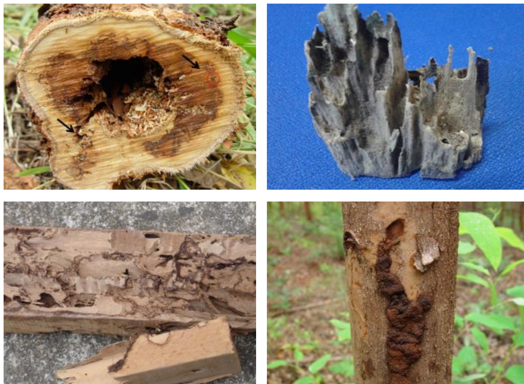
Figura 2 – Danos provocados na madeira por meio da ação de cupins.
