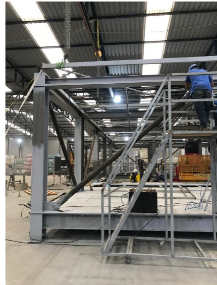
Foto 6 – Execução da estrutura metálica Visita à fábrica – Empresa A Fonte: a autora (2020)
