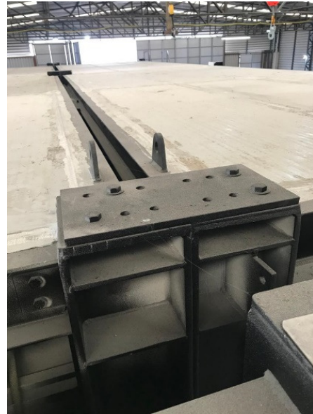
Foto 30 – Consolidação estrutural entre módulos Caso 5 – Empresa A Fonte: Empresa A (2021)
