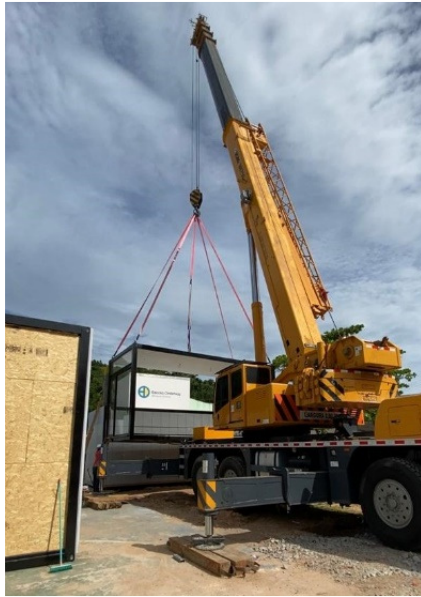
Foto 31 – Maquinário para montagem Caso 2 – Empresa B Fonte: a autora (2021)
