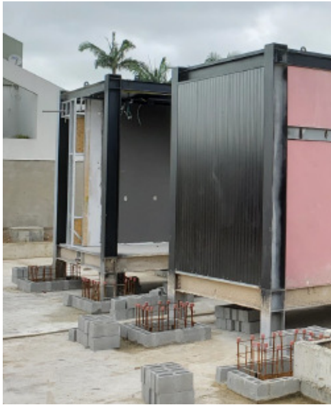
Foto 29 – Consolidação estrutural com a fundação Caso 5 – Empresa A Fonte: Empresa A (2021)
