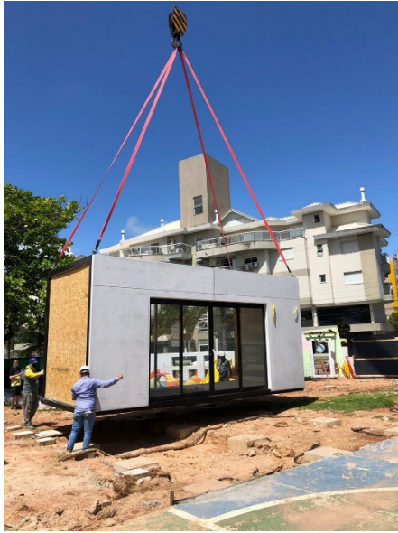
Foto 27 – Posicionamento do módulo Caso 2 – Empresa B Fonte: Empresa B (2021)
