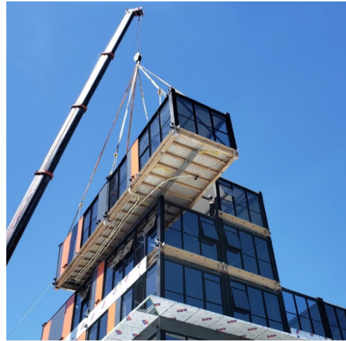
Foto 32 – Montagem de módulos Caso 5 – Empresa A Fonte: Empresa A (2021)
