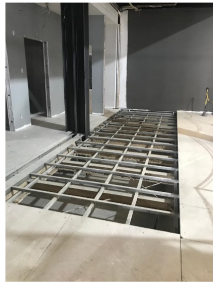
Foto 8 – Estruturas de sustentação para as lajes em painel Wall Caso 5 – Empresa A Fonte: a autora (2020)
