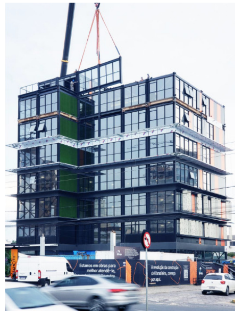
Foto 34 – Montagem de módulos Caso 5 – Empresa A Fonte: Empresa A (2021)
