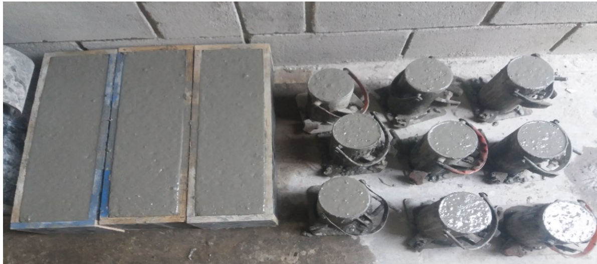
Figura 14 – Moldagem dos corpos de prova
