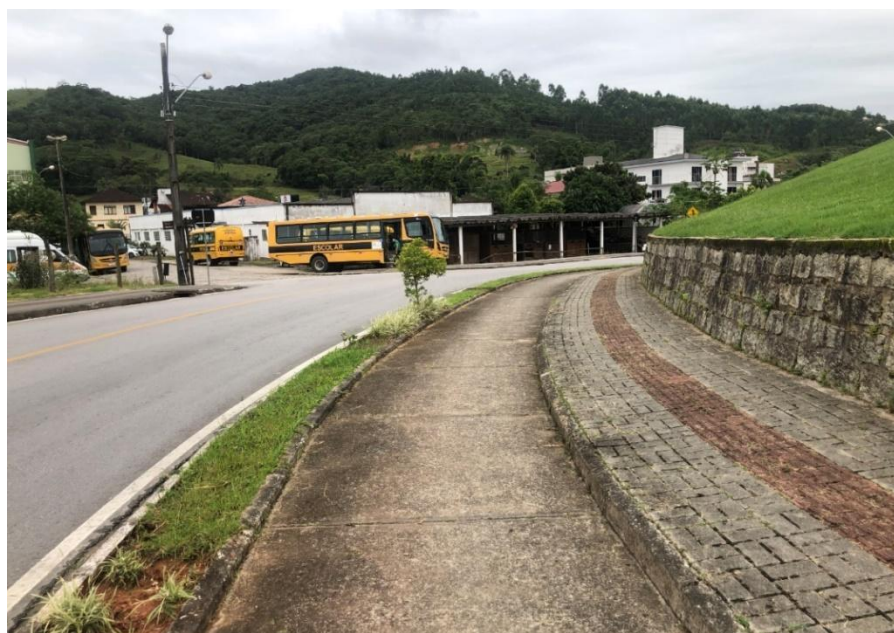
IMAGEM 43: Porção da R. João Antônio Besen que conta com calçada e ciclovia. Fonte: Acervo
