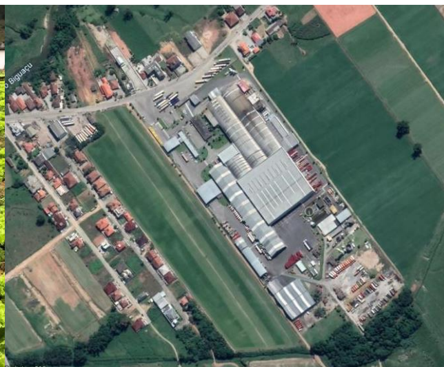
IMAGEM 8: Área da fábrica da Coca-Cola. Fonte: Google Earth
