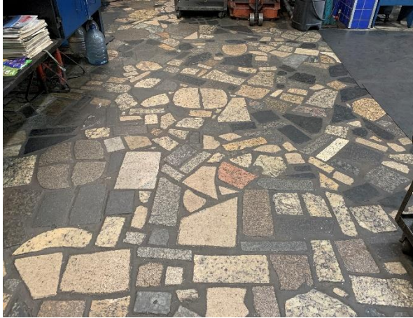
Figura 41 – Piso argamassado com pedras de mármore
