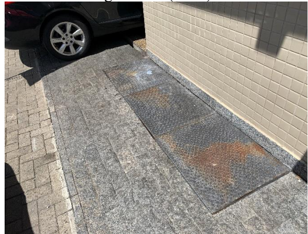
Figura 12 – Cobertura do Sistema Separador Água Óleo (SAO)
