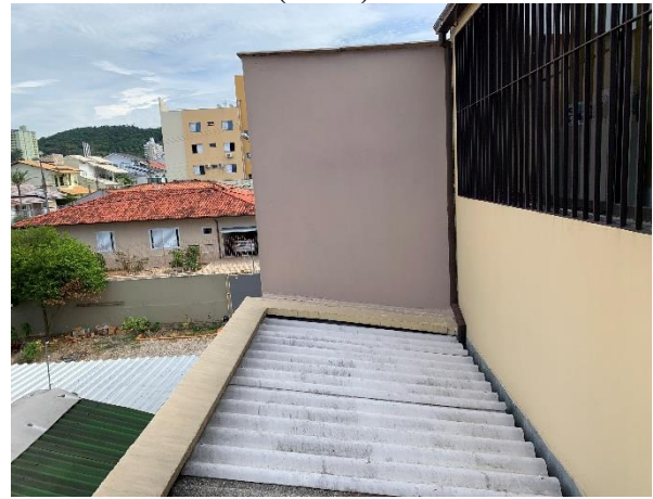
Figura 46 – Localização do reservatório (aérea)
