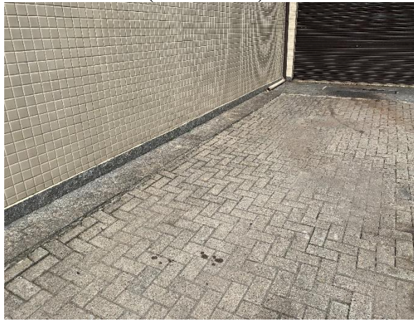
Figura 45 – Localização do reservatório (subterrânea)
