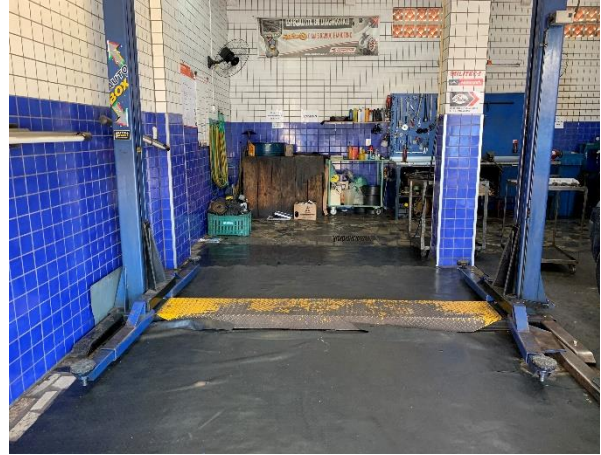
Figura 42 – Utilização de tapetes de borracha impermeáveis
