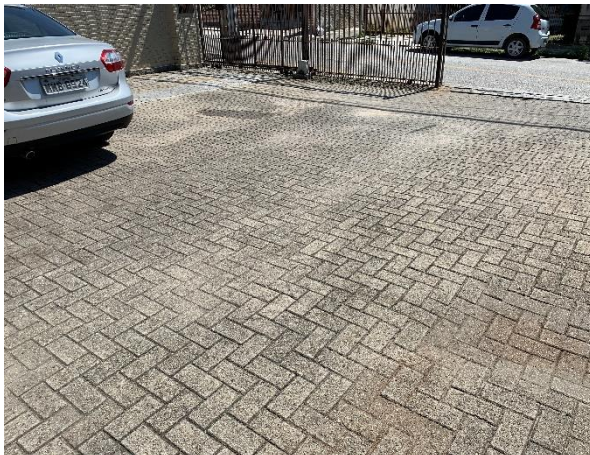
Figura 43 – Pavimento intertravado de concreto
