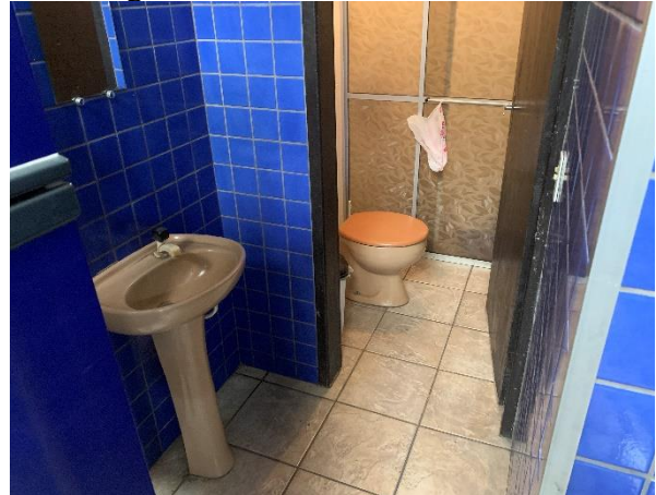
Figura 14 – Banheiro e lavatório
