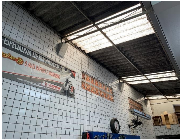
Figura 47 – Vista inferior do telhado a ser substituído
