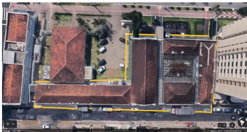
Figura 36 – Vista superior da edificação anterior ao restauro
