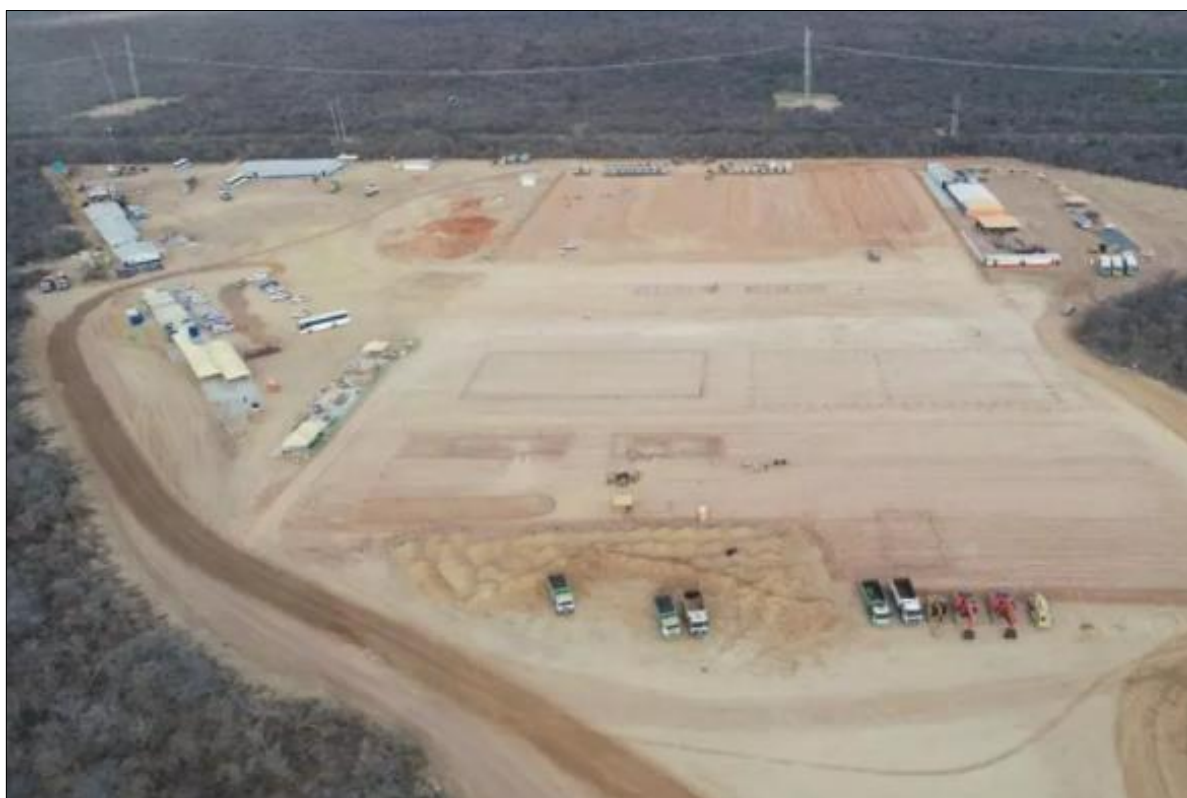
FIGURA 7: CANTEIRO DE OBRAS – EMPREENDIMENTO
