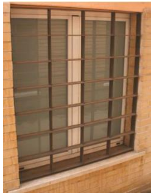
(b) Janela de alumínio após retrofit
