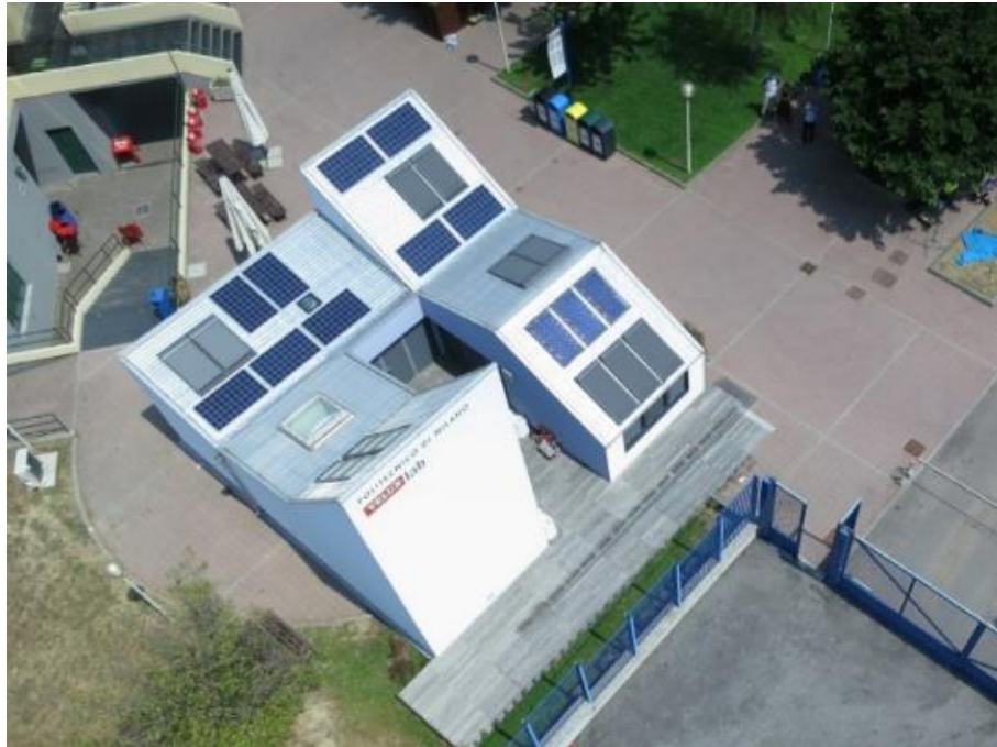
Figura 9 – Instalação de painéis fotovoltaicos e coletores solares sobre a cobertura de uma edificação
