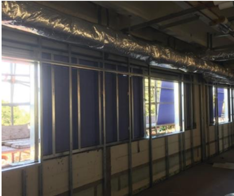
Figura 6 – Melhoria no sistema de climatização a partir do isolamento dos dutos de ar
