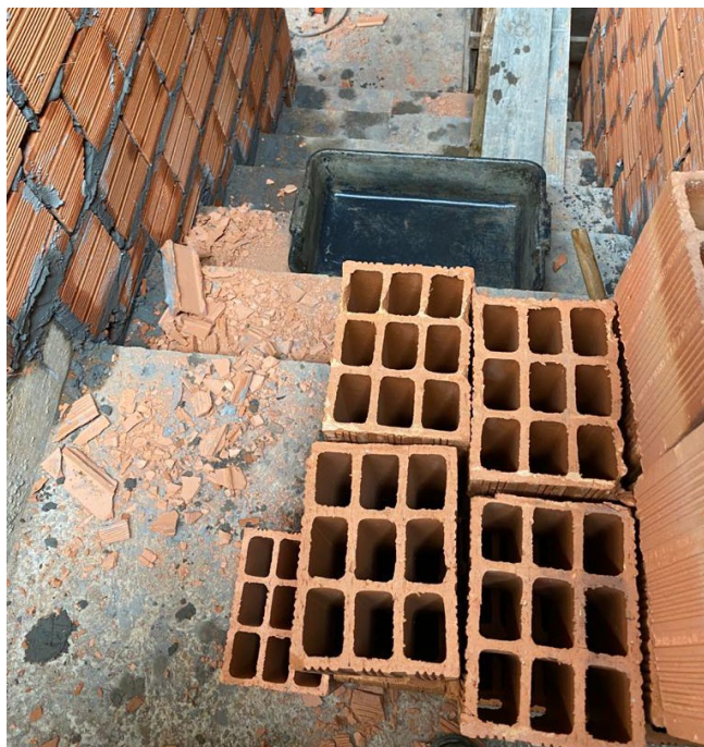
Figura 32 – Tijolos cerâmicos dispostos para elevação de alvenaria
