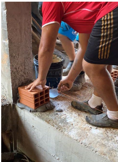
Figura 16 – Marcação da parede
