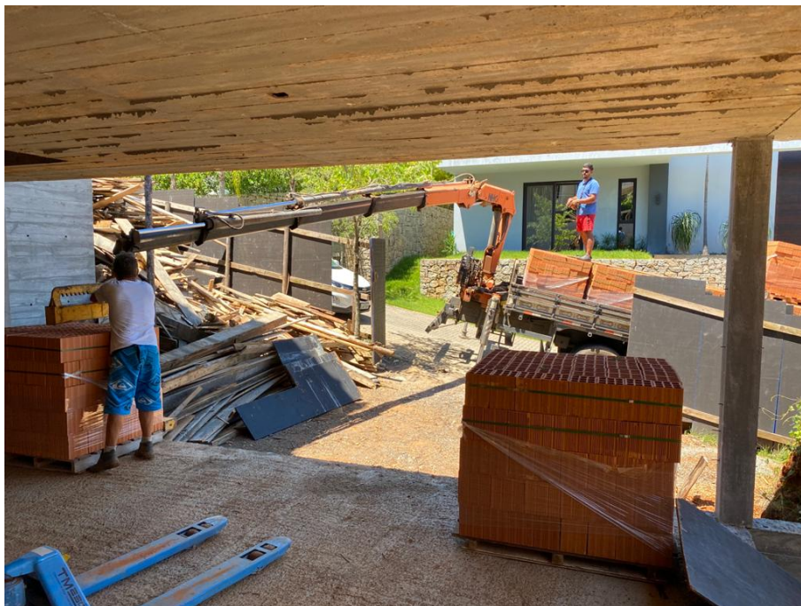
Figura 18 – Provisão de blocos
