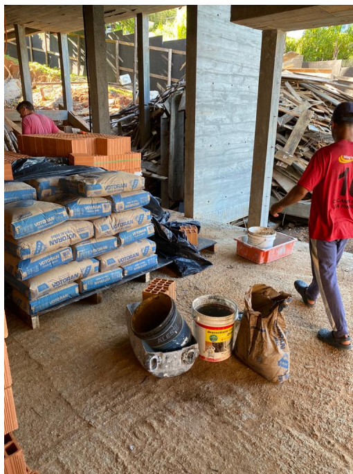
Figura 33 – Armazenamento dos sacos de cimento no canteiro de obras
