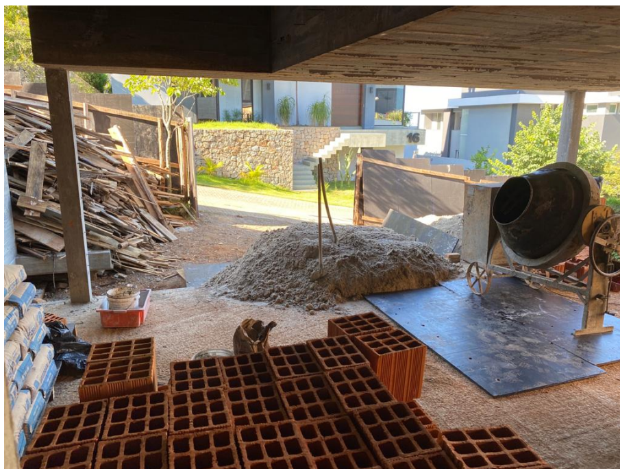
Figura 29 – Canteiro de obras
