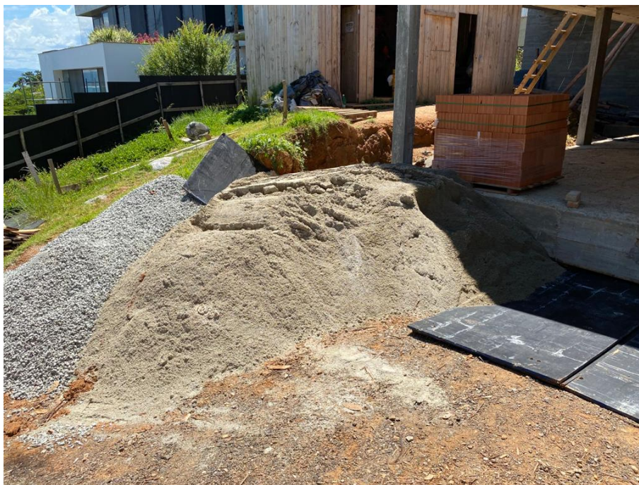
Figura 36 – Areia estocada no canteiro de obras
