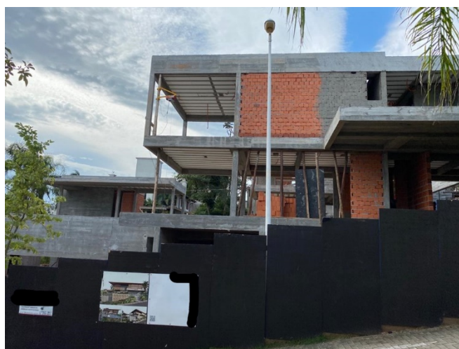
Figura 28 – Fachada frontal da residência em fase de elevação de alvenaria
