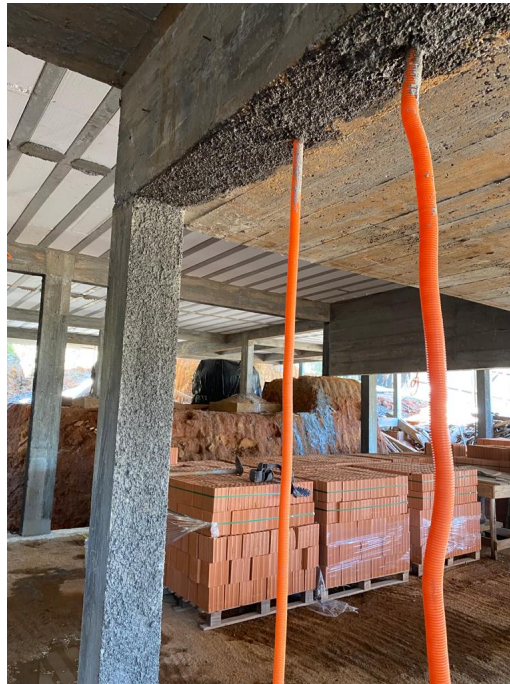
Figura 14 – Chapisco sobre a estrutura
