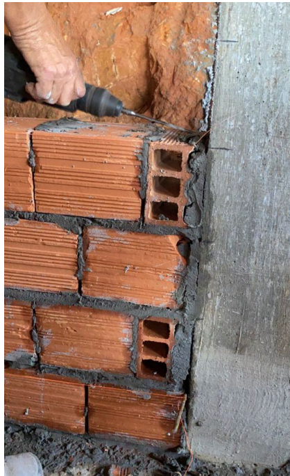
Figura 17 – Amarração lateral com pilar
