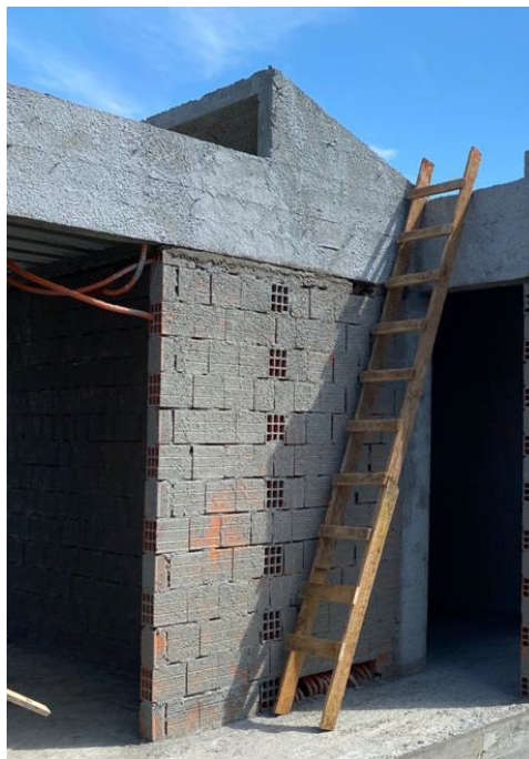
Figura 21 – Fixação da parede
