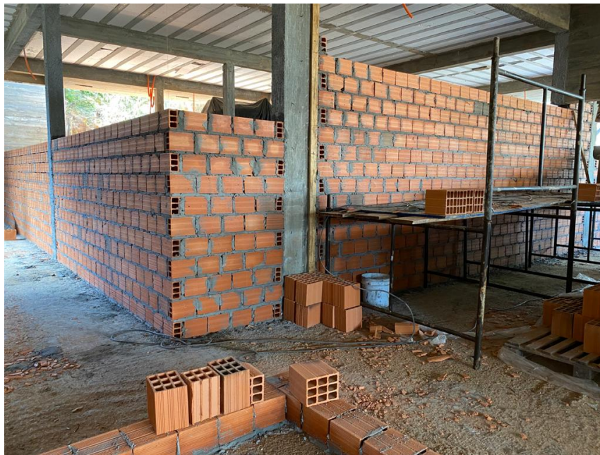
Figura 13 – Execução de alvenaria de vedação
