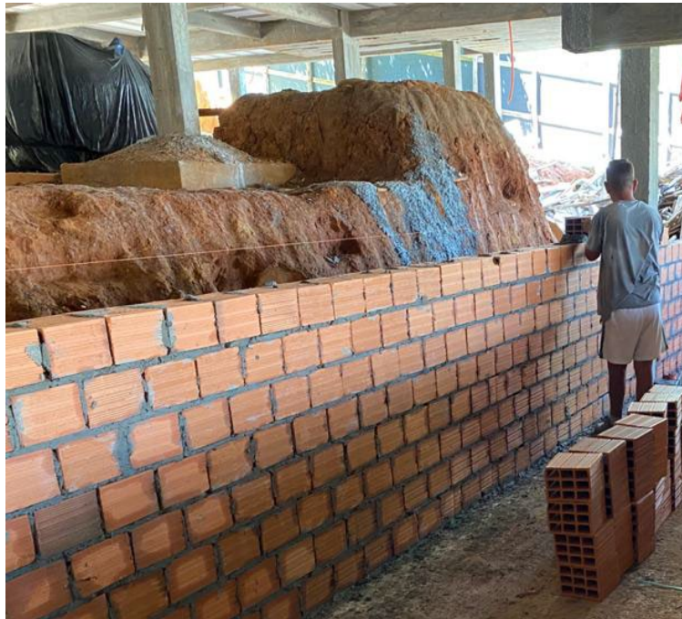
Figura 19 – Elevação da parede
