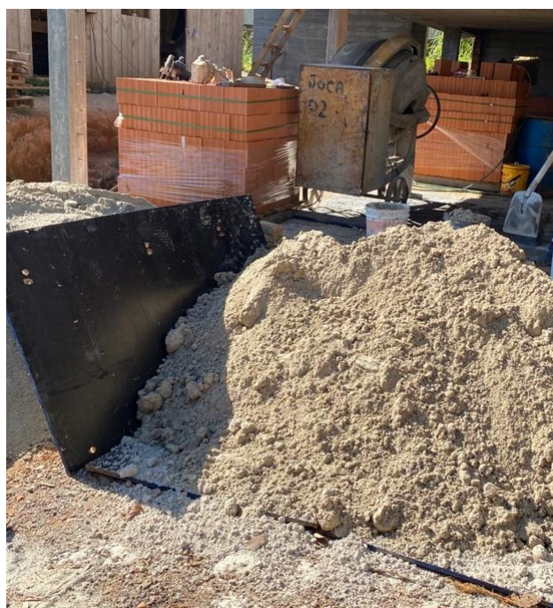
Figura 34 – Argamassa no canteiro de obras
