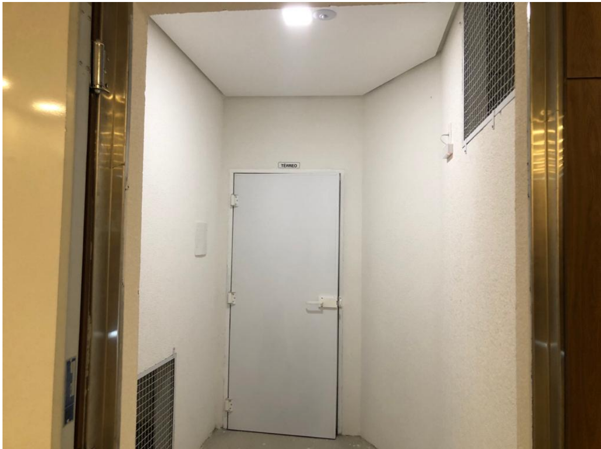
Figura 27 – DEF e DEA presentes na antecâmara de uma PF
