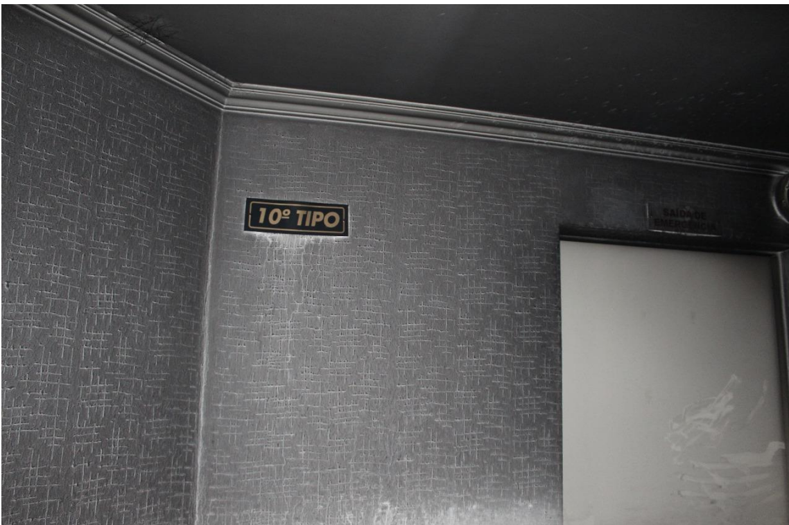
Figura 34 – Marcas da fumaça e calor
