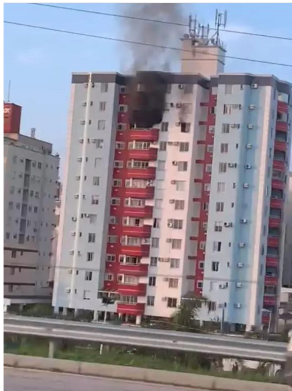
Figura 31 – Fumaça saindo da sacada e janelas do apartamento
