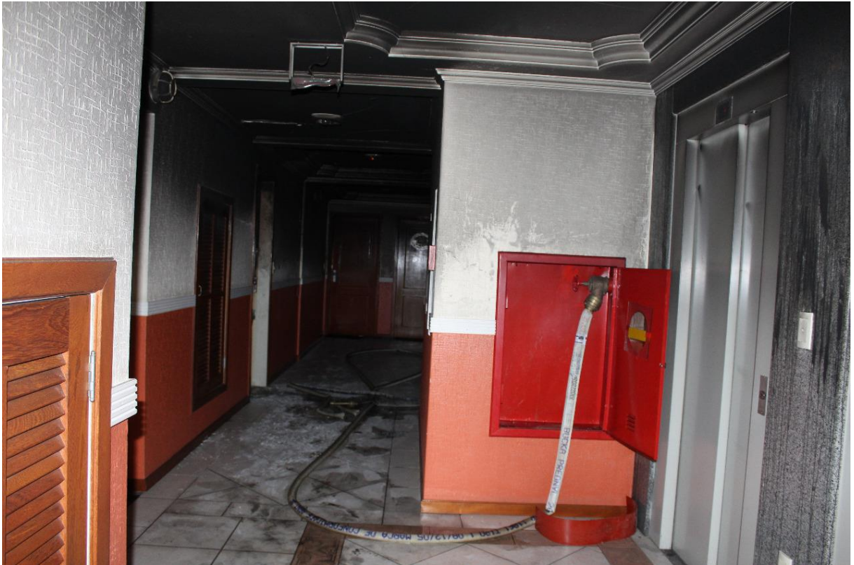
Figura 35 – Corredor do 10º pavimento
