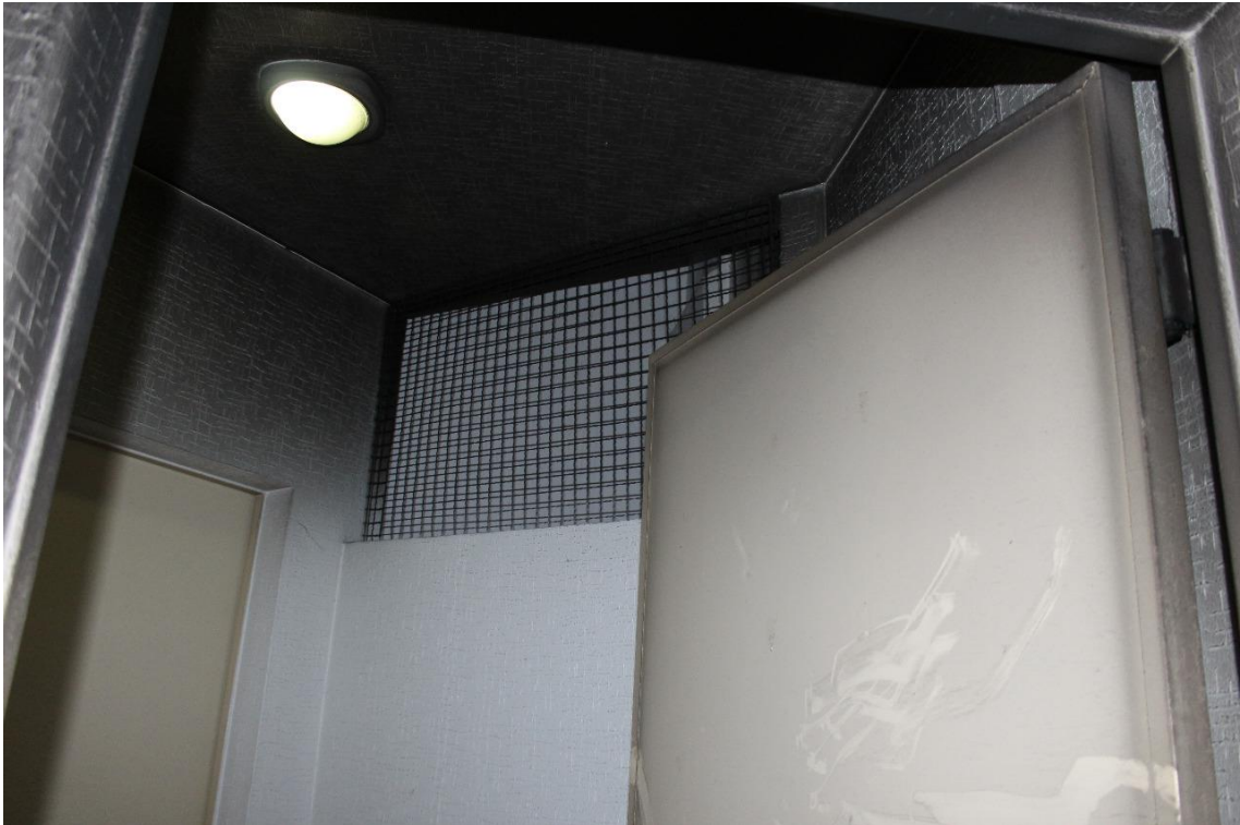
Figura 33 – DEF localizado na antecâmara
