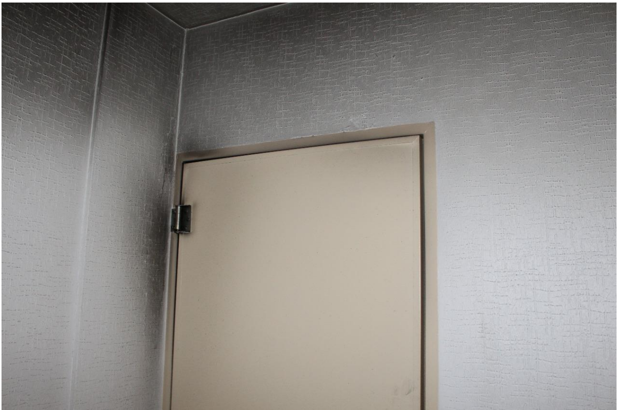
Figura 32 – Porta Corta-Fogo vista de dentro da antecâmara
