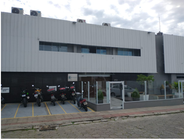
Figura 4.1: Entrada da empresa Khomp.
