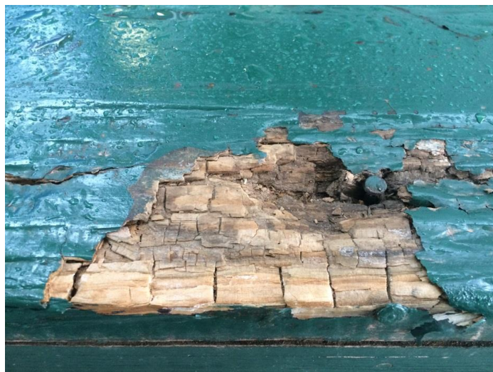
Figura 2: Madeira atacada por fungos de podridão parda Fonte: Elaborada pelo autor, 2015.
