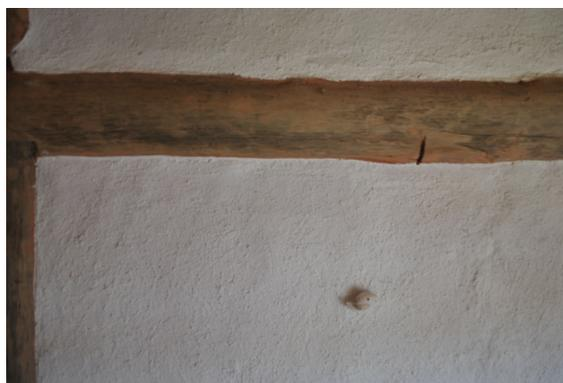
**Figura 15: reboco com a segunda camada finalizada**
