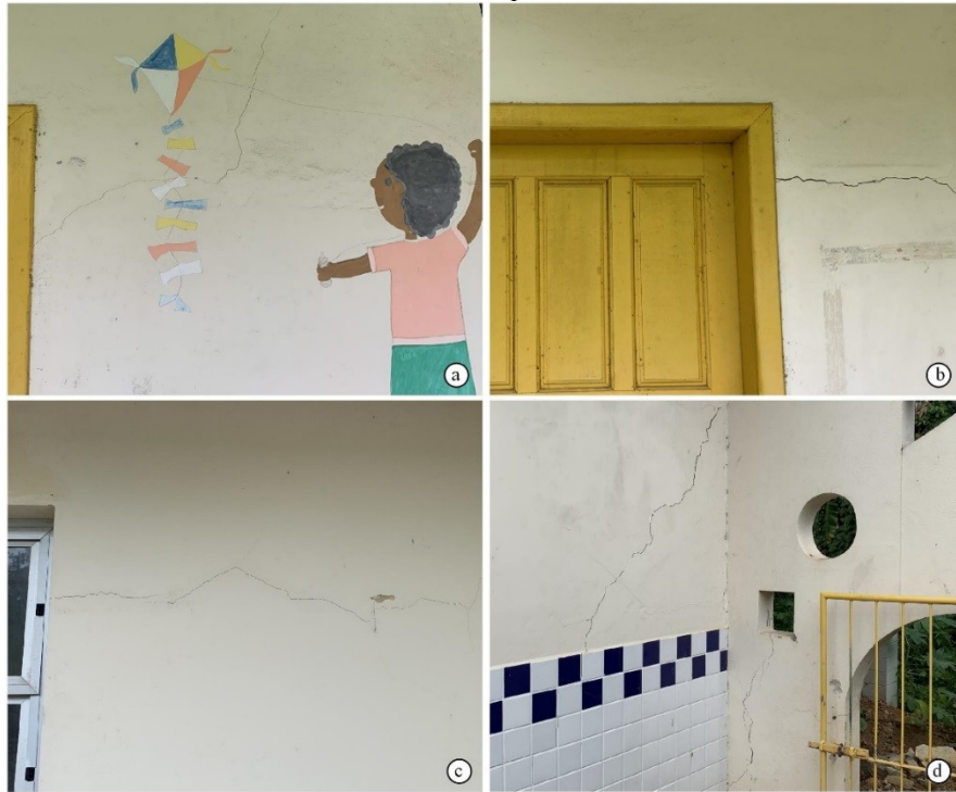
Figura 28: Bloco mais a montante da Escola Anísio Teixeira (a) fissura inclinada com espessura de 0,5 mm (b) trinca horizontal com espessura de 0,7 mm (c) fissura horizontal com espessura de 0,4 mm (d) trinca inclinada com espessura de 0,6 mm.
