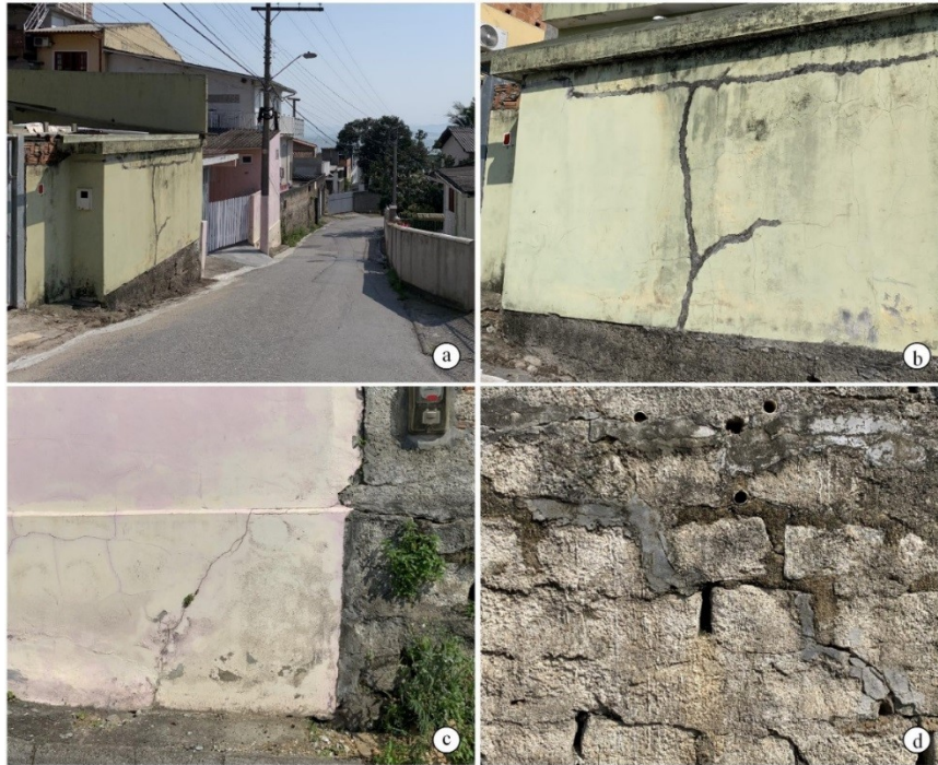
Figura 33: Área próxima à Escola, na Servidão José Kumakola, foram observadas edificações apresentando deterioração (a) rachaduras horizontais, verticais e inclinadas no muro de alvenaria (b) abertura centimétrica das rachaduras (c) trincas verticais no muro de alvenaria (d) rachaduras com abertura centimétrica no muro de pedra.
