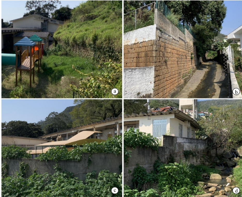
Figura 27: Drenagem e obras eficientes de contenção de talude ineficientes. (a) muro de pedra em alguns cortes realizados sem sistema de drenagem associado (b) muro de pedra com presença de água vertendo (c) muro de alvenaria sem sistema de drenagem associado. (d) muro de alvenaria sem sistema de drenagem associado.
