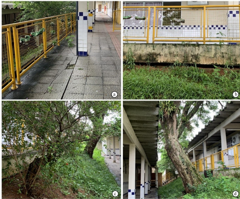
Figura 30: Espaço entre o bloco mais a montante e central da Escola Anísio Teixeira (a) (b) calçada situada em frente a esta sala de aula, evidenciando uma possível ruptura (c) (d) árvores inclinadas, evidenciando uma possível ruptura.
