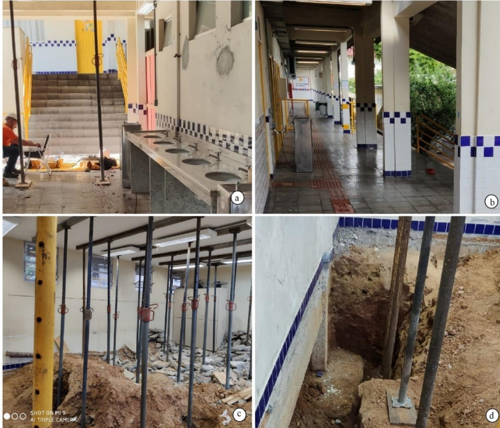
Figura 31: Bloco central da Escola Anísio Teixeira (a) (b) diversas fissuras longitudinais à calçada situada em frente a esta sala de aula, evidenciando uma possível ruptura (c) escoramento em toda sala de aula, possibilitando a avaliação da gravidade da ruptura das vigas e paredes (d) escavação de aproximadamente dois metros, efetuada junto a um pilar de fundação dentro da sala de aula do bloco que apresentou as deteriorações, no que se constatou um espaço vazio entre sapata e pilar de arranque.
