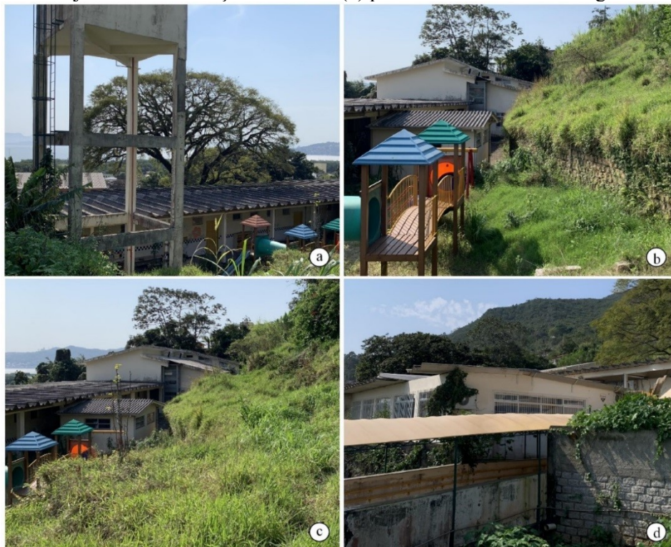
Figura 23: A Escola Anísio Teixeira (área de estudo) se encontra em ambiente de encosta (terço médio a inferior) (a) caixa d'água e sala de aula (b) (c) cortes e aterros decorrentes da ocupação antrópica objetivando construção da Escola (d) passarela sobre o curso d'água.
