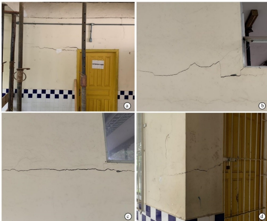
Figura 29: Bloco central da Escola Anísio Teixeira (a) trinca horizontal com espessura de 0,7 mm próximo a porta (b) (c) trinca horizontal com espessura de 0,6 mm próximo a uma das janelas (d) trincas horizontais com espessura de 0,7 mm próxima a uma porta.
