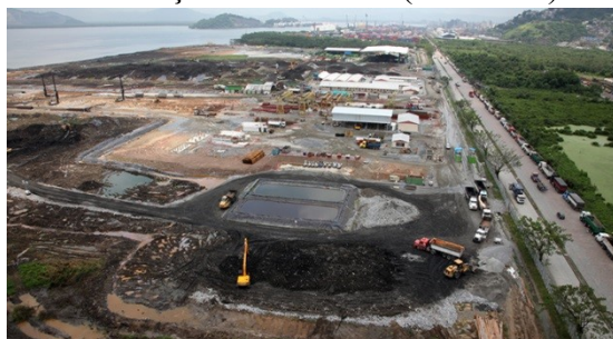
Figura 36 - Início das obras para construção do terminal (out. 2010)
