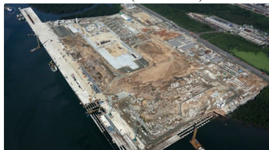
Figura 37 - Obras para construção do terminal (mar. 2012)
