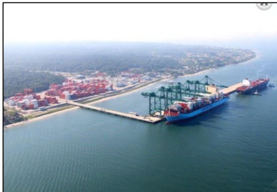
Figura 56 - Vista aérea do cais
