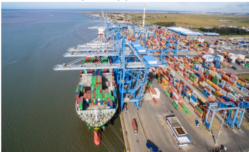
Figura 77 - Equipamentos no cais
