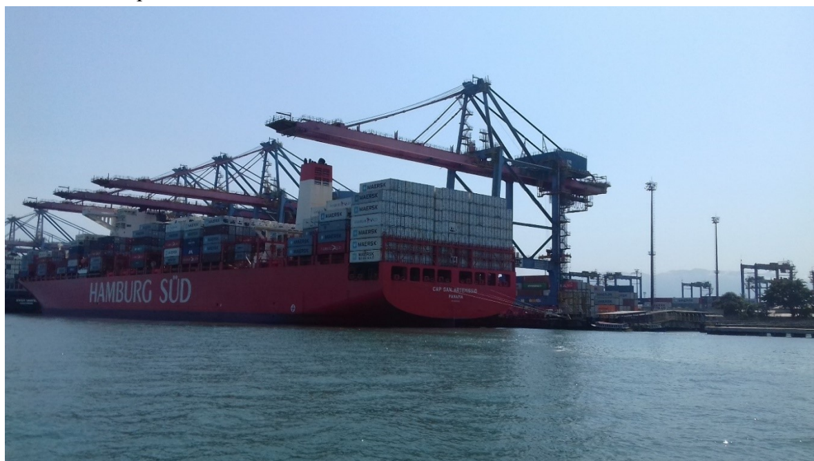
Figura 33 - Navio do armador Hamburg Süd atracado em um dos berços do terminal Santos Brasil, 4 portêineres da marca chinesa ZPMC movimentam contêineres no navio
