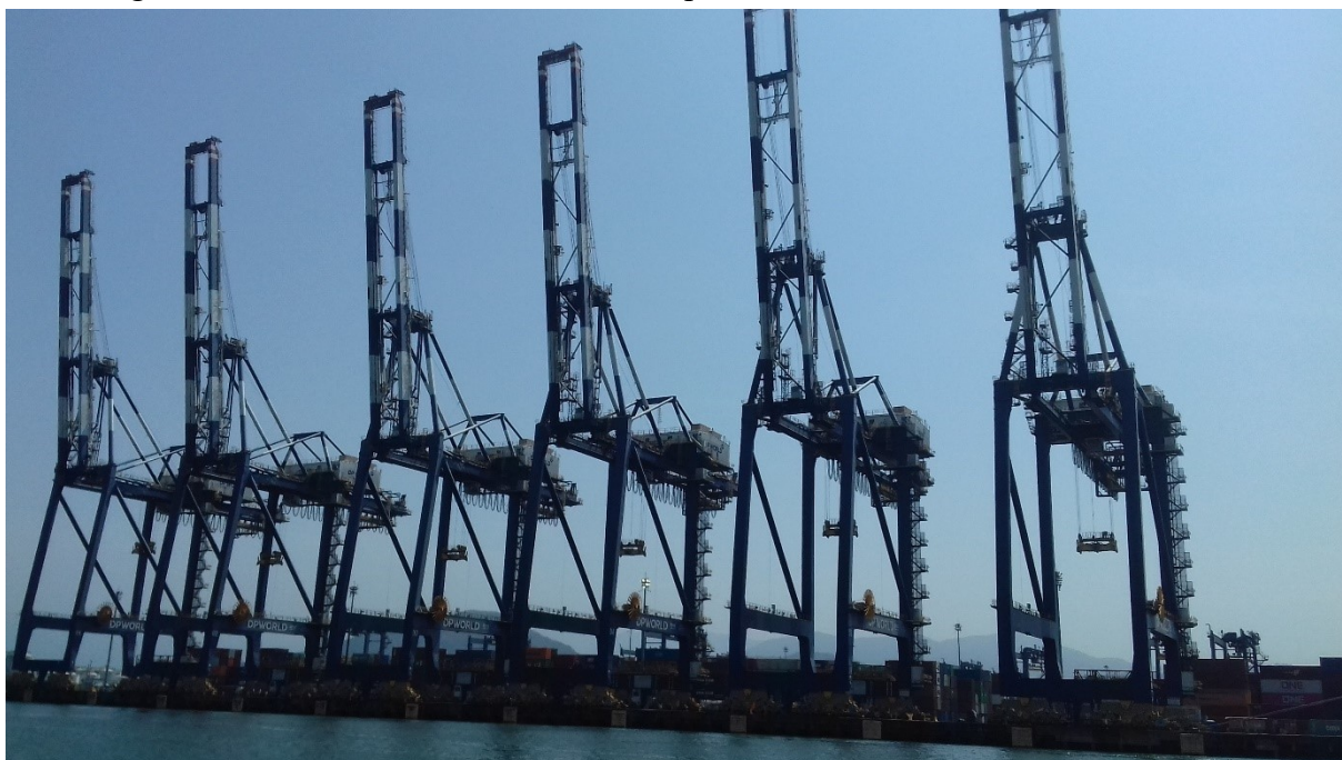
Figura 47 - Terminal DP World Santos - portêineres da fabricante chinesa ZPMC
