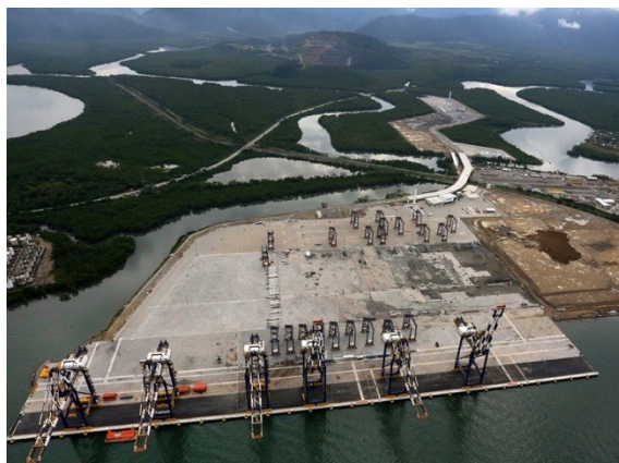
Figura 42 - Conclusão da 1ª fase (2013)
