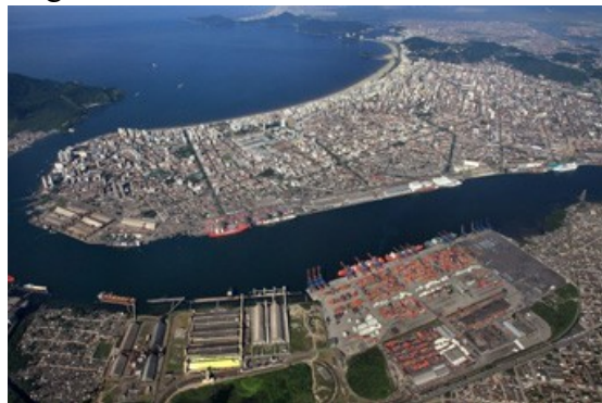
Figura 30 - Vista aérea do canal de acesso
