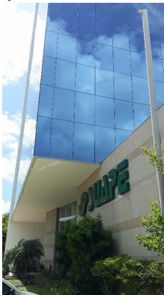
Figura 95 - Prédio da Autoridade Portuária
