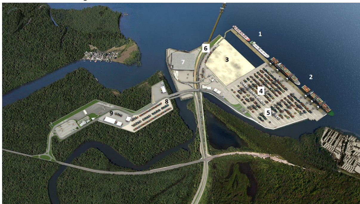
Figura 48 - Infraestrutura do Terminal DP World Santos
