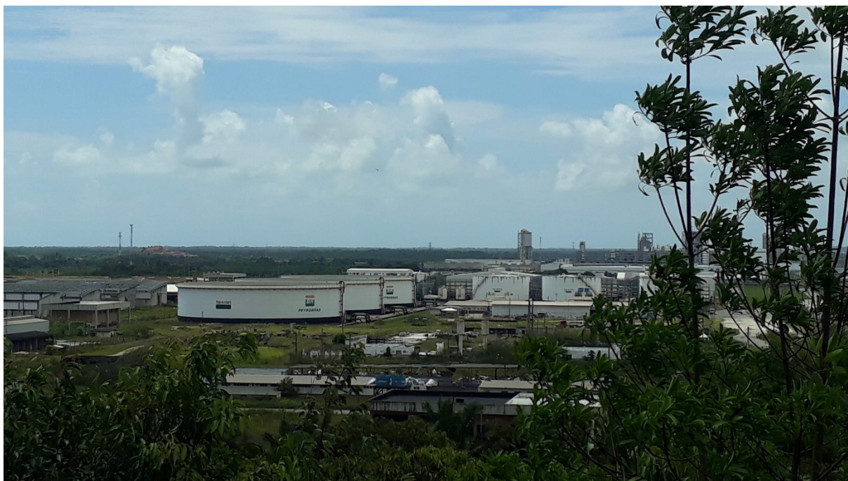
Figura 93 - Parque de tancagem da Petrobras, no Complexo Industrial Portuário de Suape
