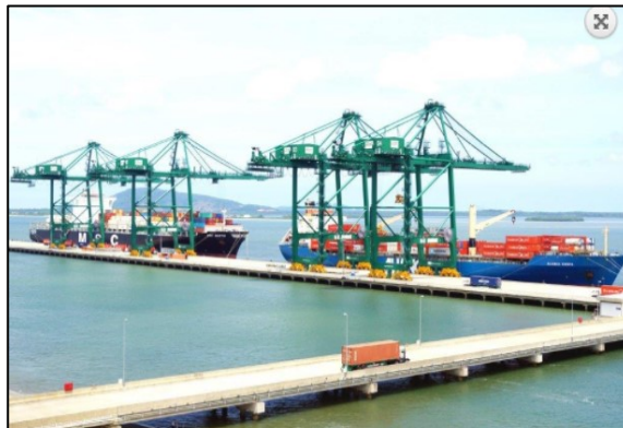
Figura 57 - Operação nos 2 berços de atracação
