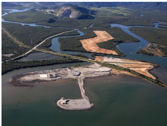
Figura 40 - Início das obras - aterro piloto (2007)
