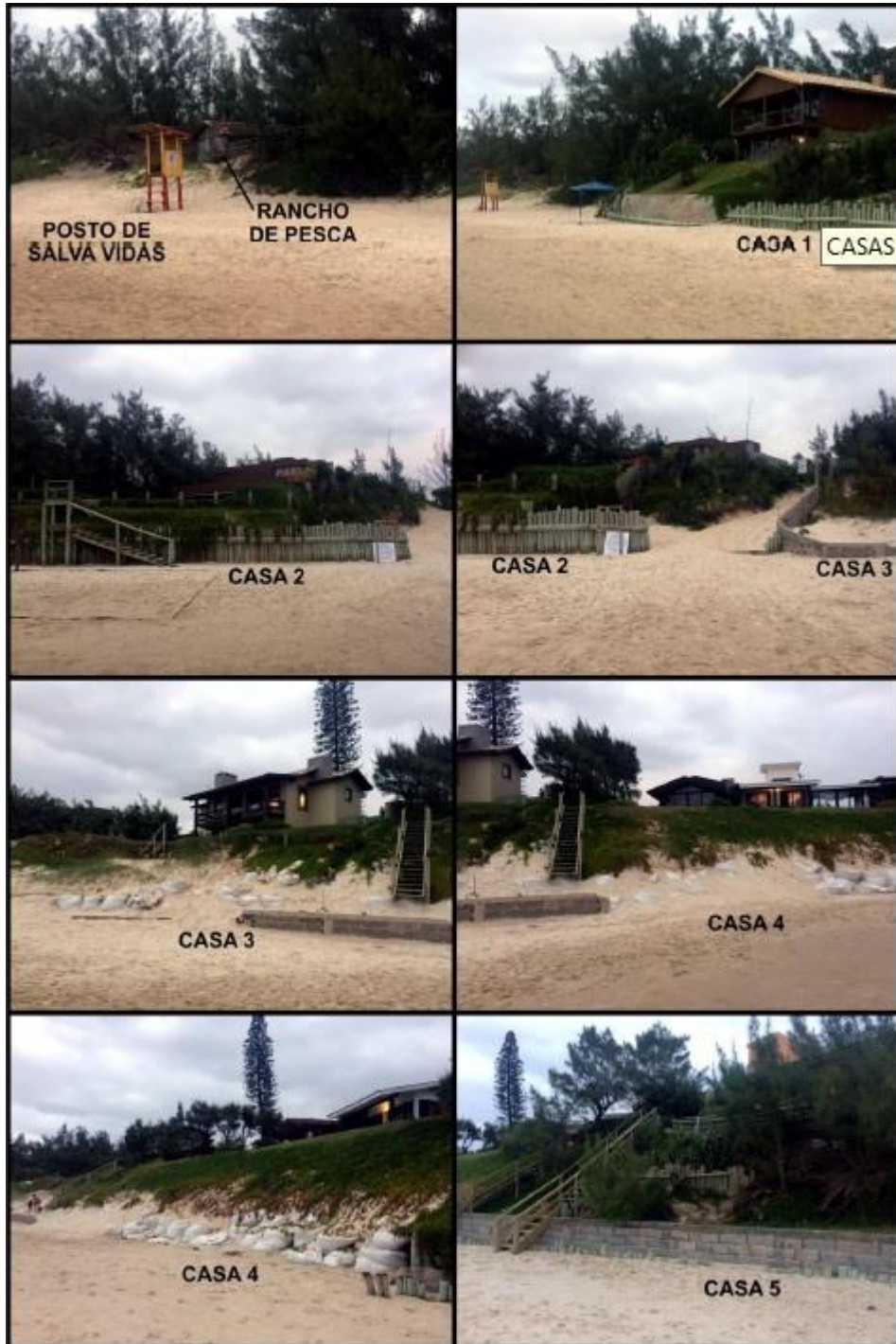
Figura 21. Estruturas de contenção da erosão costeira, Praia da Barra.
