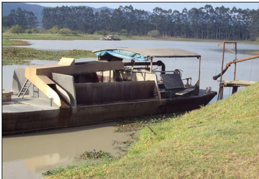
FIGURA 13: BALSA FLUTUANTE EM CAVA INUNDADA
