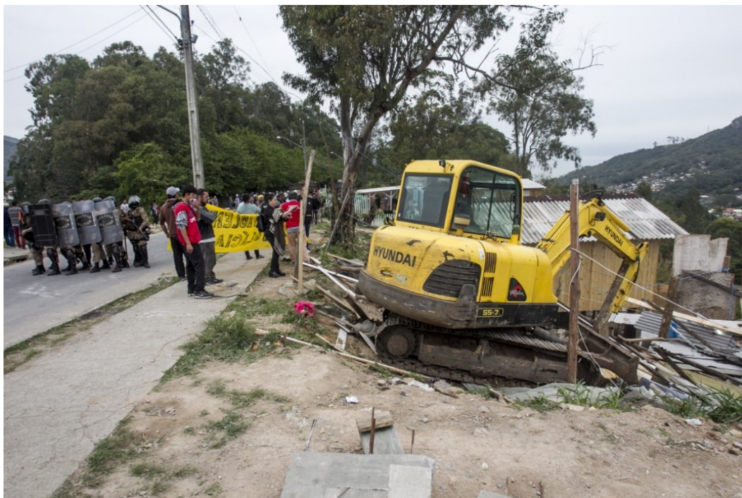
Figura 10 - Demolição de casas na Ocupação Marielle Franco
