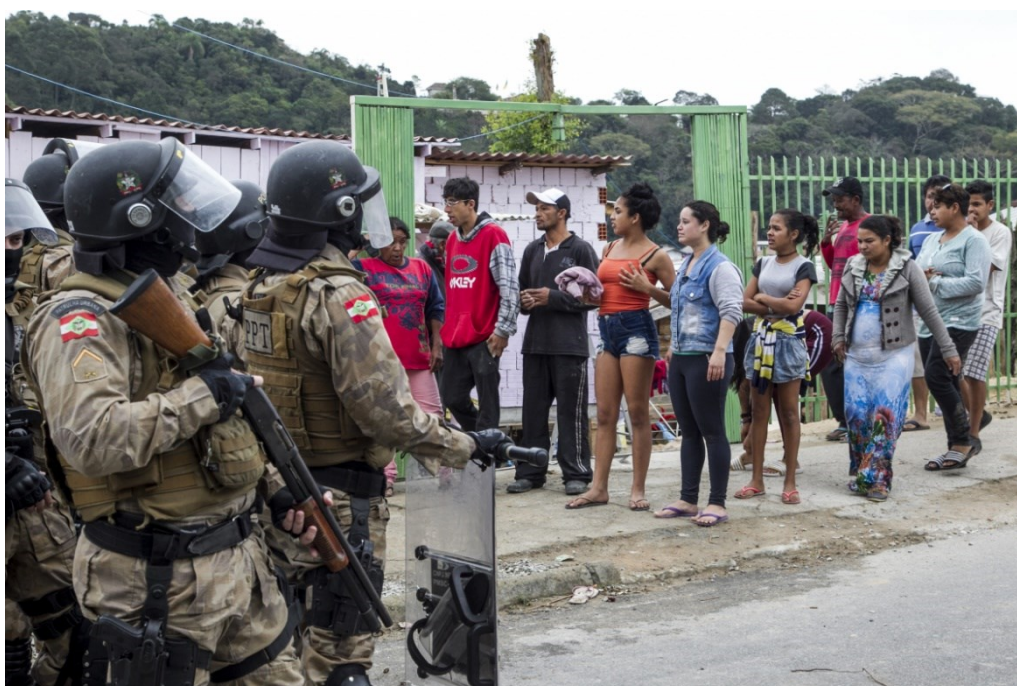
Demolição de casas na Ocupação Marielle Franco (13/06/2018). Fotografia: Marco Santiago
