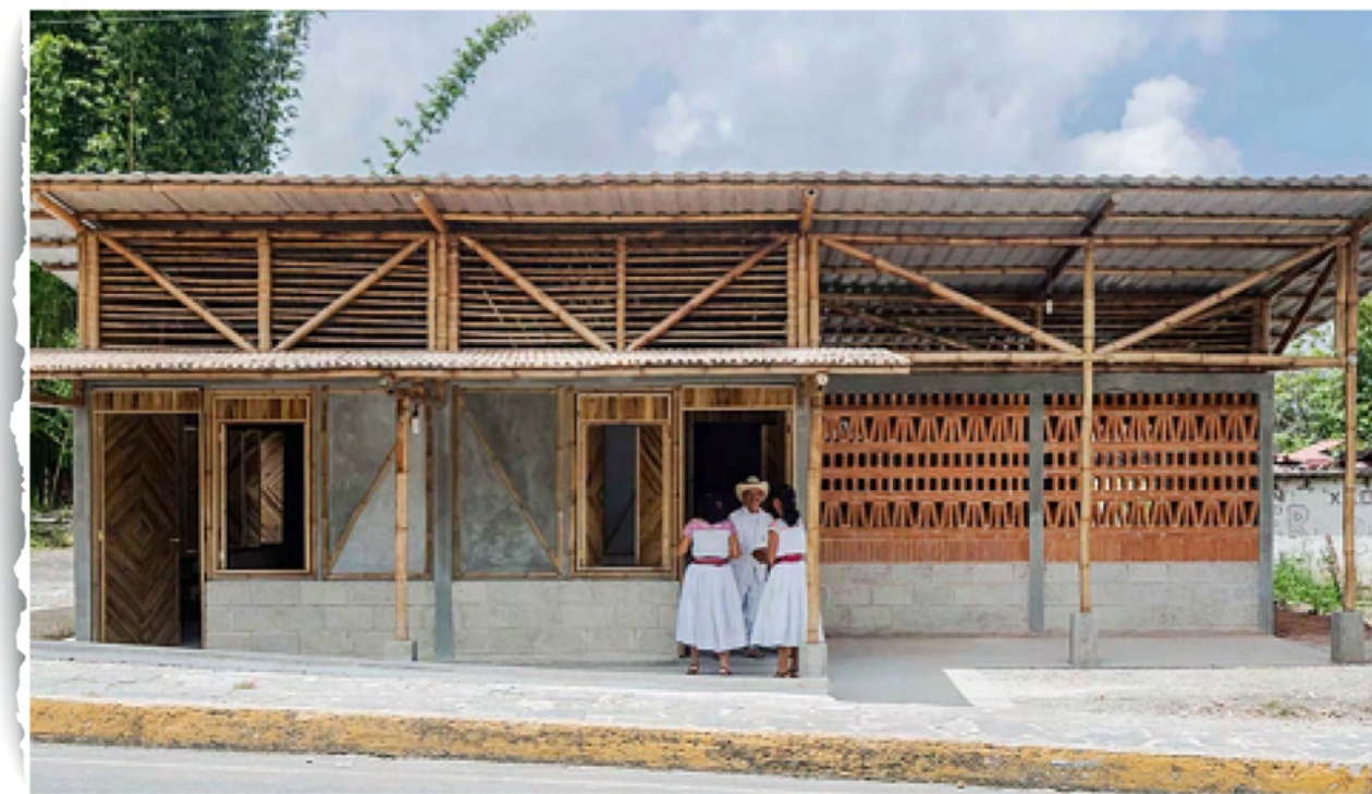
Figura 67: Protótipo para habitação social. Fonte: Sustentarqui, 2018
