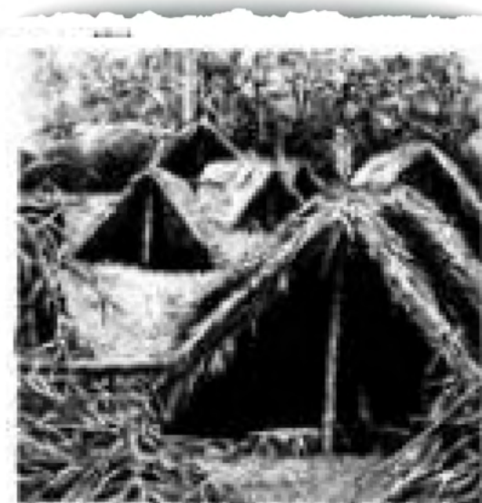
Figura 27: Aldeamento com cobertura de palha orientado para favorecer a ventilação, em MT. Fonte: Weimer, 2014
