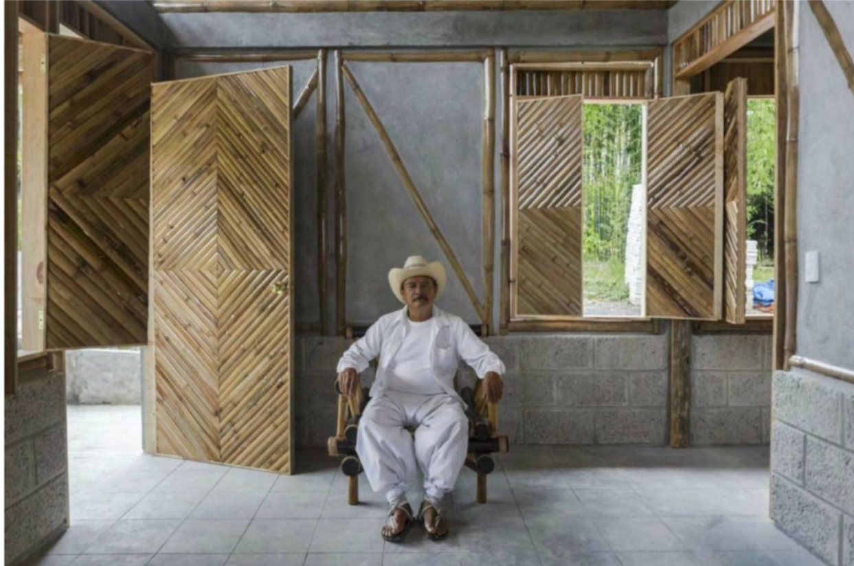
Figura 68: Esquadrias de bambu. Fonte: Sustentarqui, 2018
