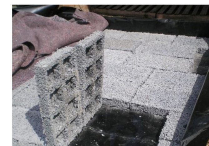
Colocação dos módulos de piso elevado sobre laje impermeabilizada Fonte: www.ecotelhado.com.br
