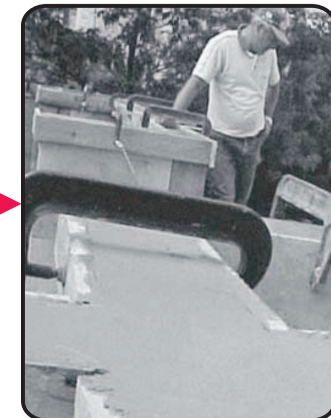
sarrafeamento dos painéis
