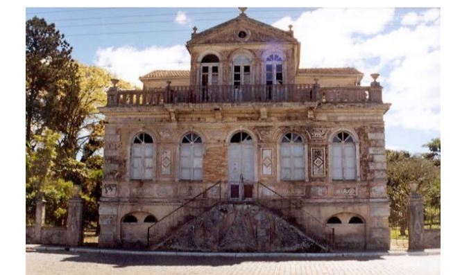
Mansão da família Gallotti, edificada em 1898, é uma construção significativa e reflete o apogeu econômico de Tijucas no final do século XIX e início do século XX. Tombada pelo Estado, hoje pertence ao Rotary Clube de Tijucas, mas está abandonado e em condições precárias. Foto: www.studioqfara.com.br
