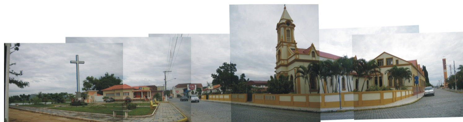
Conjunto Capela (1921) e Colégio Espírito Santo, construído na década de 1910, teve esta função até 1974 e hoje abriga o Lar de Idosos Santa Maria da Paz. Em frente, a Praça do Divino.
