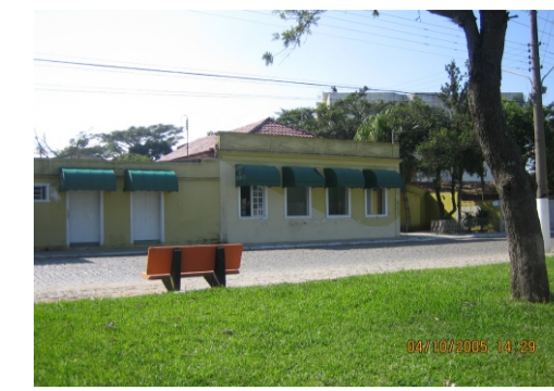
Residência em estilo colonial construída em 1878.
