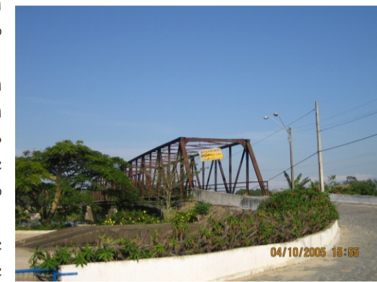
Ponte Bulcão Viana.
