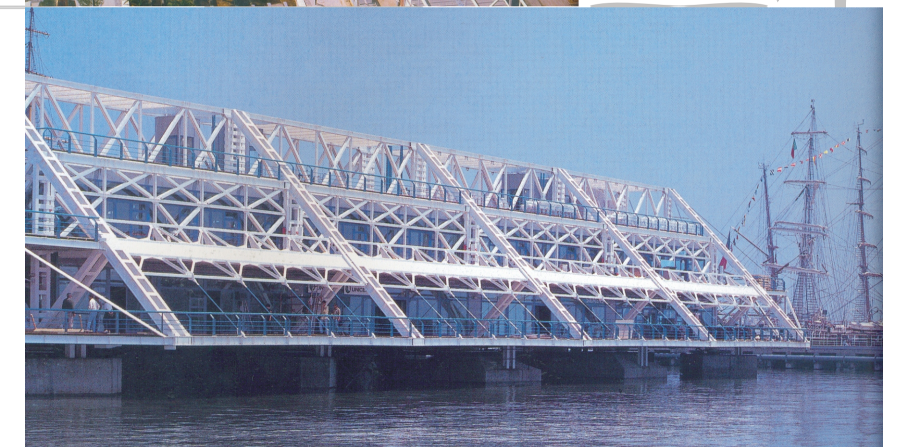
Circulação coberta integrada ao edifício; modulação bem marcada
