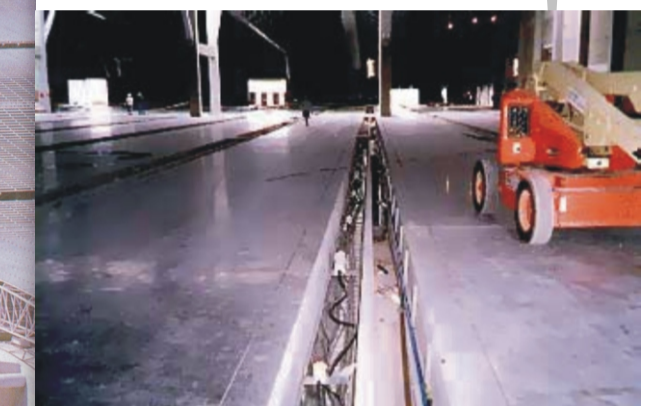
▲ Canaletas no piso para passagem de fiação e tubulação
