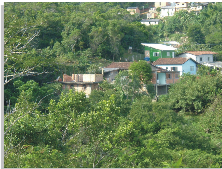
Imagem 28 – Ocupações irregulares sendo construídas no Morro do Quilombo
