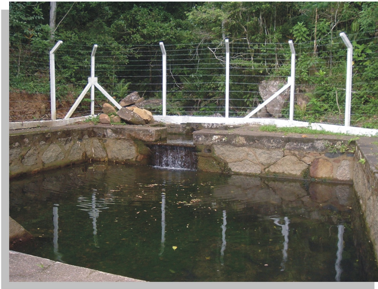
Imagem 07 – Represa no Córrego Itacorubi, localizada no Morro do Quilombo – Captação da água.
