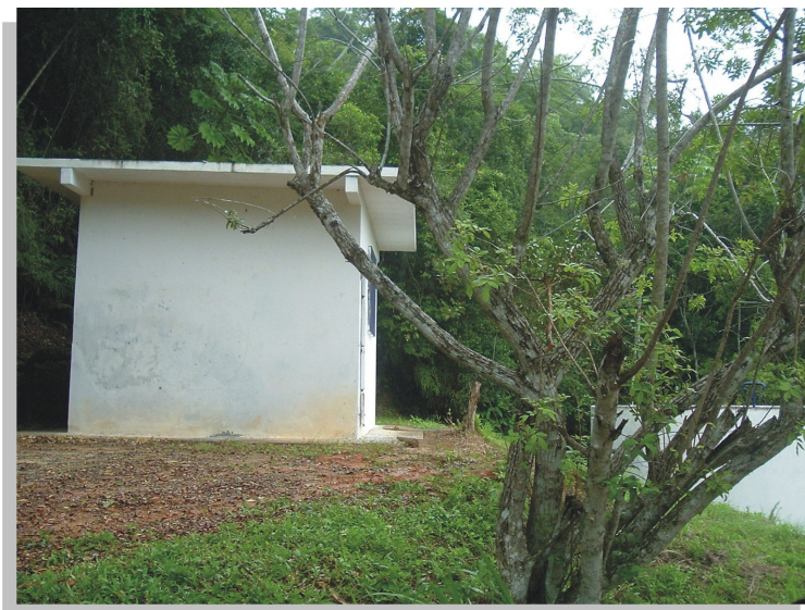
Imagem 10 – Casa de Química da Represa, localizada no Morro do Quilombo.
