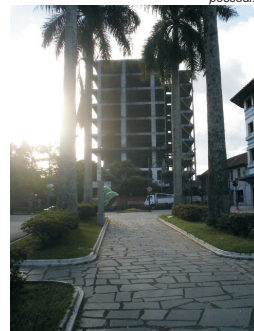
Lateral do Edifício América visto da Alameda Duque de Caxias. Fonte: Acervo pessoal.
