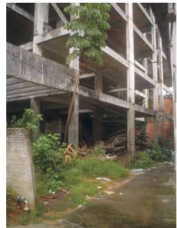
Lateral do Edifício América. Fonte: Acervo pessoal.
