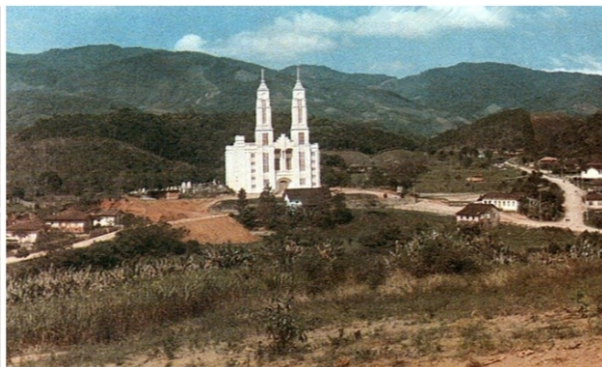
Vista do centro da cidade em 1967, após inauguração da Igreja Matriz Fonte: JUNCKES, 2006
