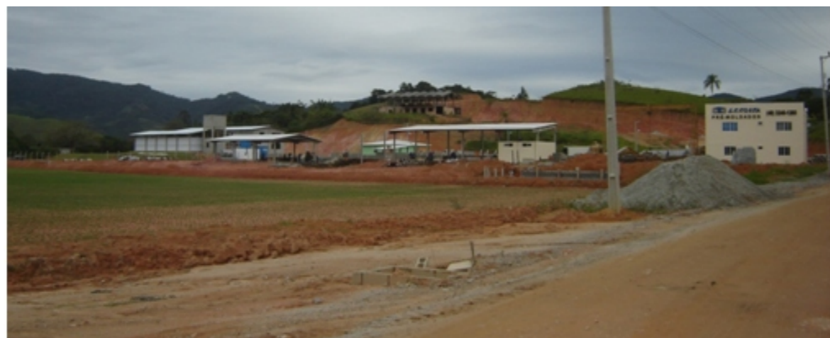
Área destinada à implantação de novas indústrias, durante a pavimentação da rua. Fonte: Acervo pessoal
