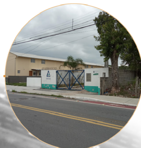
Estação elevatória da CASAN localizada logo ao lado do terreno escolhido
