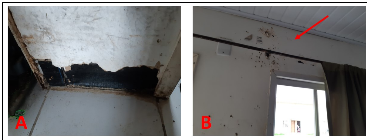
Figura 181 - A - chapa de gesso acartonado danificada no rodapé por umidade por limpeza e B – furos nas paredes para colocação de objetos.
