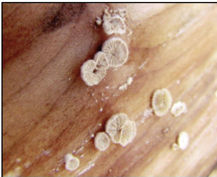
Figura 76 - Presença de fungos dentro das paredes nas chapas de contraventamento.
