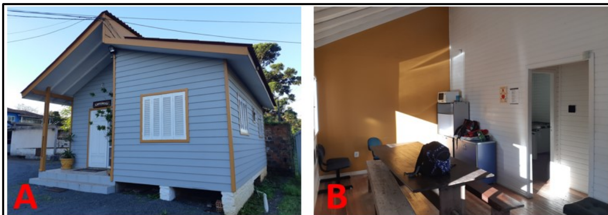
Figura 123- A – Exterior e B – Interior (sala e cozinha) da HIS 5.
