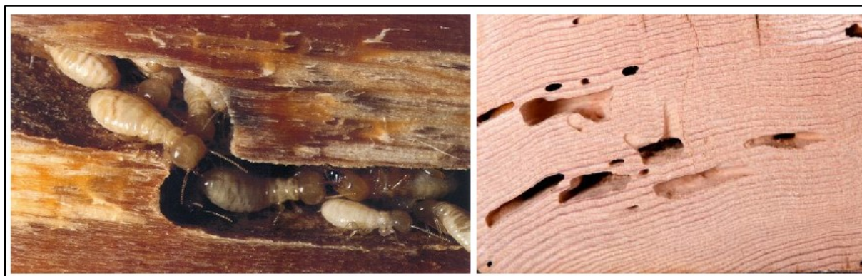
Figura 70 - Galeria e sinais de ataque de cupins de madeira seca.
