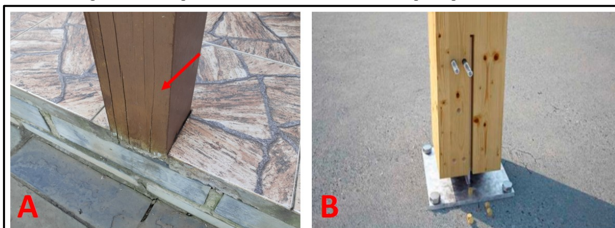
Figura 173 - A- pilar da HIS 10 e B- um modelo de porta pilar metálico.
