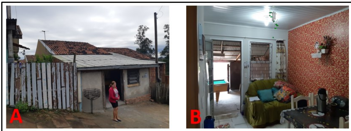
Figura 146 - A - vista externa e B – vista interna da HIS 8.
