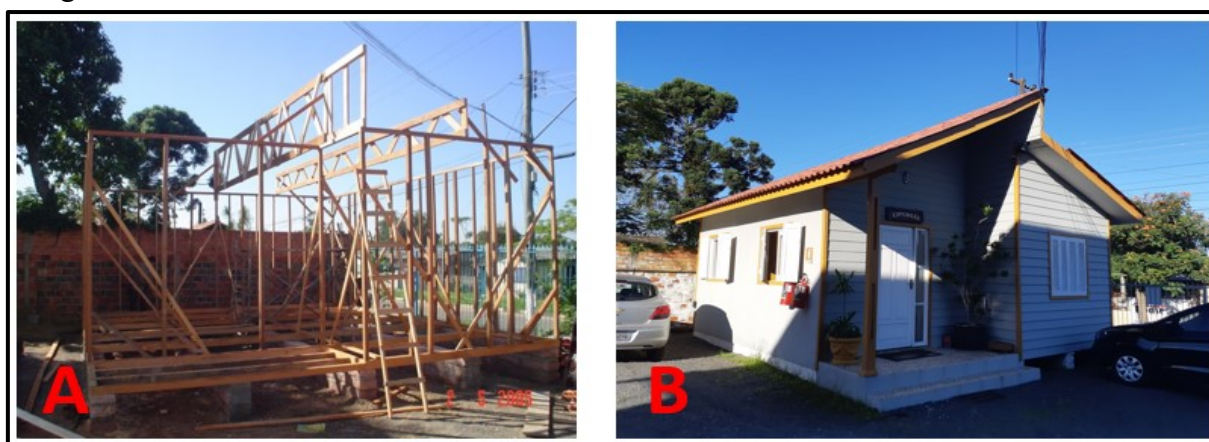
Figura 122 - A- Ossatura sendo construída em Maio de 2005 e B – vista da HIS em 2019.
