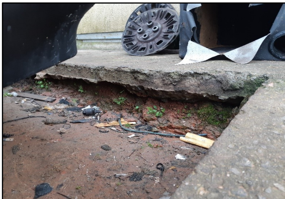
Figura 142 - Imagem da fundação (radier) e do aterro da HIS 7.
