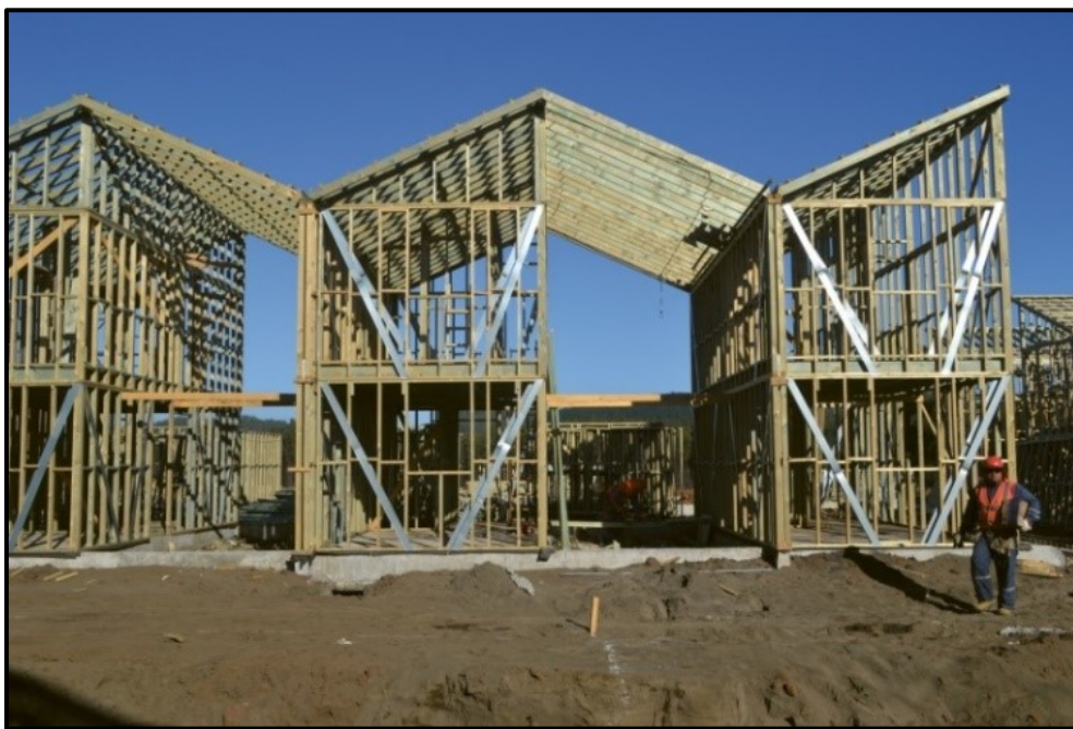
Figura 1 - Estrutura de madeira das Habitações do Villa Verde.
