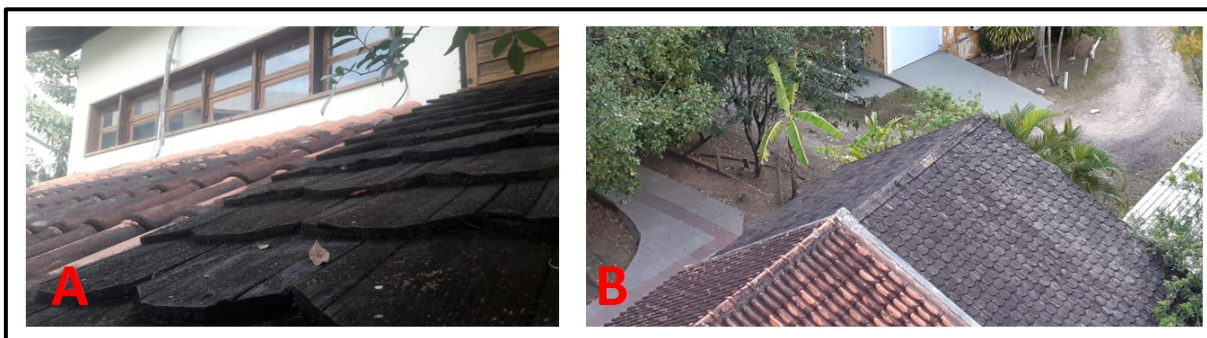
Figura 186 A - B: Telhas da HIS 10 apresentando escurecimento causados por microorganismos nas orientações norte e sul e cobertura cerâmica ao lado seguindo o mesmo padrão de escurecimento.
