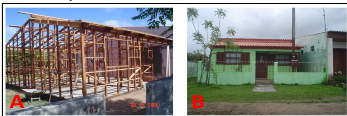
Figura 108 - A – ossatura de madeira e B – fachada da HIS 3.
