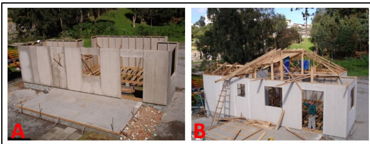
Figura 130 - A e B – Construção da HIS 6.
