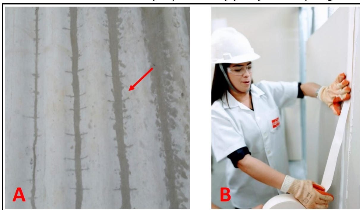
Figura 177 - A – trincas transversais em telhas de fibrocimento ocasionadas por caminhamento direto na telha e B – aplicação de fita de papel na junta da chapa de gesso.
