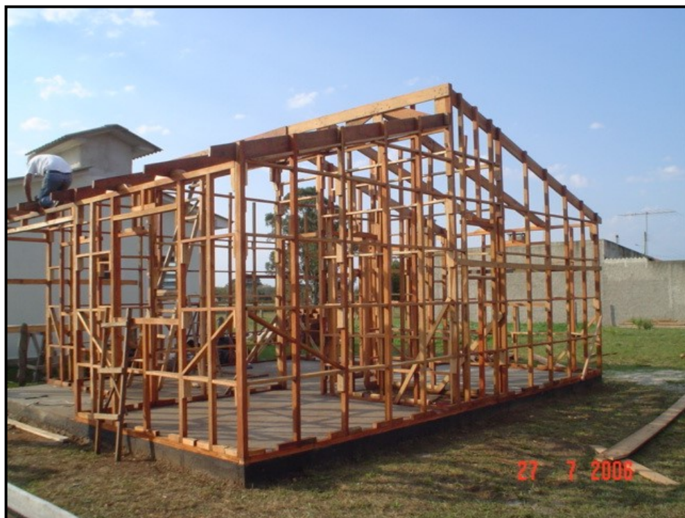
Figura 115 - Ossatura de madeira da HIS 4 em construção.
