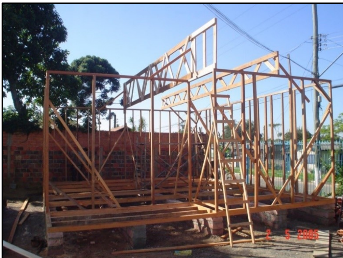
Figura 24 - Residência montada no método artesanal.
