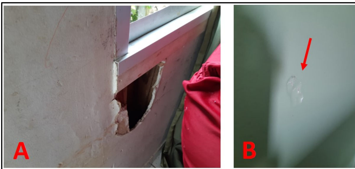
Figura 180 - A – B exemplos de manifestações patológicas causadas por usuários em chapas de gesso acartonado em HIS.
