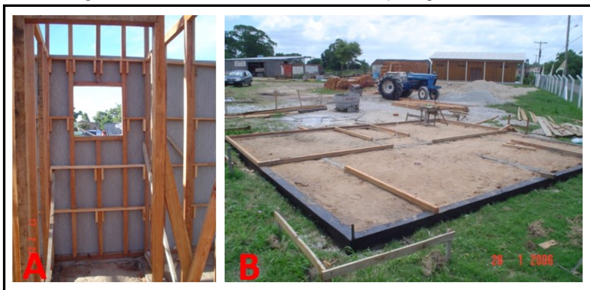
Figura 100 - A – ossatura de madeira e B – fundação impermeabilizada.
