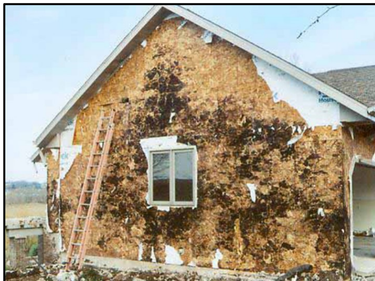
Figura 77 - Manifestações patológicas geradas por condensação nas chapas de OSB.
