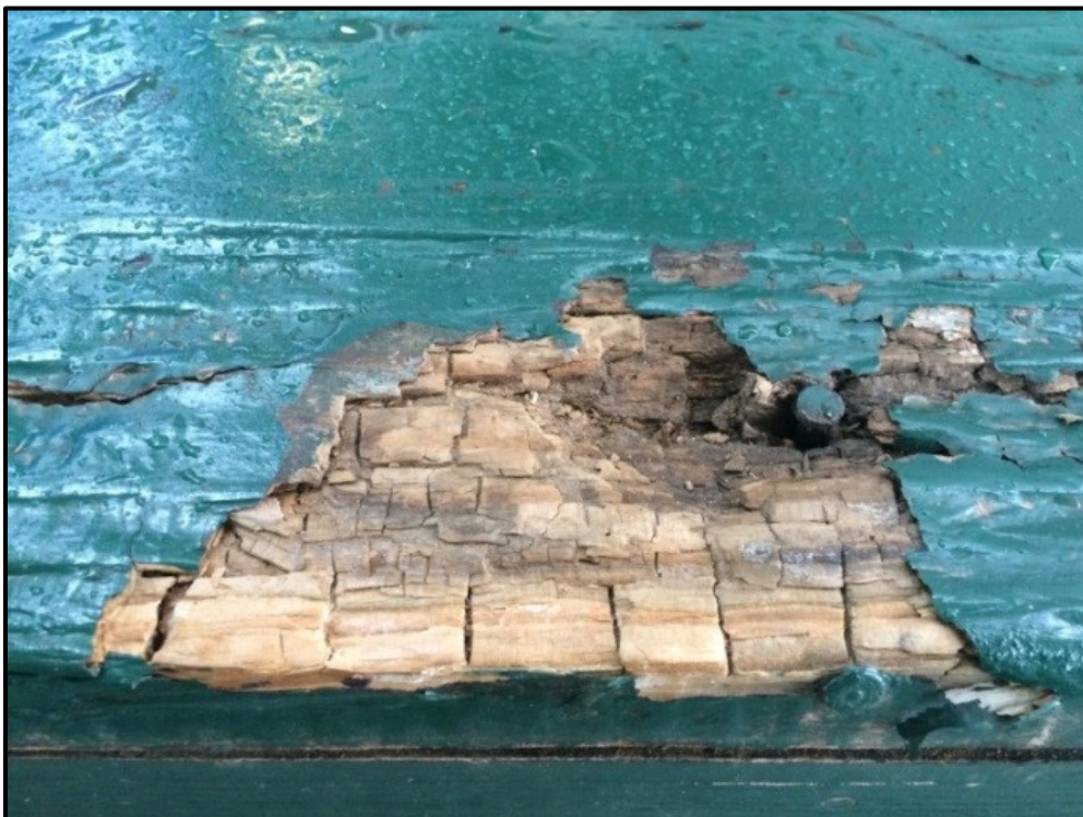
Figura 69 - Madeira atacada por fungos de podridão parda.
