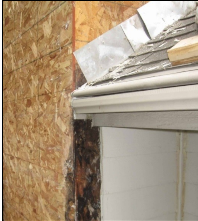
Figura 78 - Infiltração de água gerado por má instalação do acabamento da parede ( Step Flashing Roof ).
