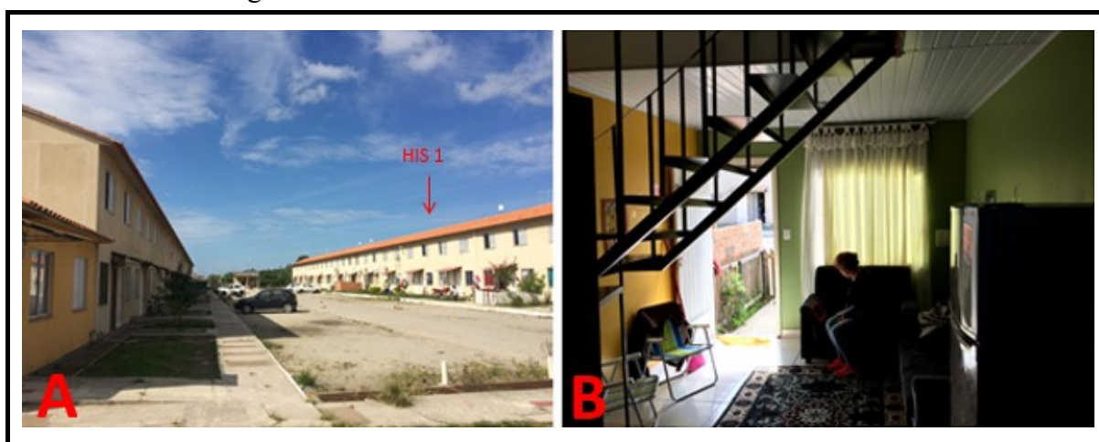
Figura 90 - A - vista externa e B – vista interna da HIS 1.
