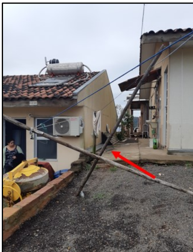
Figura 153 - Diferença de nível do terreno e parede de LWF geminada ao muro de arrimo de bloco de pedra Grês.
