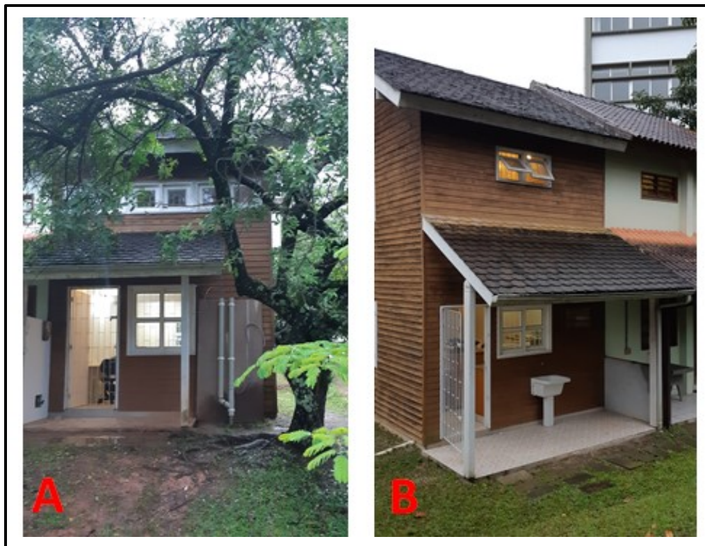
Figura 160 - A – fachada norte e B – fachada sul da HIS 10.
