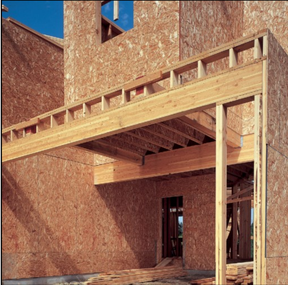
Figura 9 - Madeira Laminada Colada sendo utilizada no Light Wood Frame .
