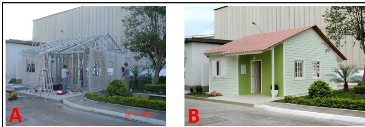
Figura 126 - A – Protótipo em construção e B – Protótipo em LSF pronto.
