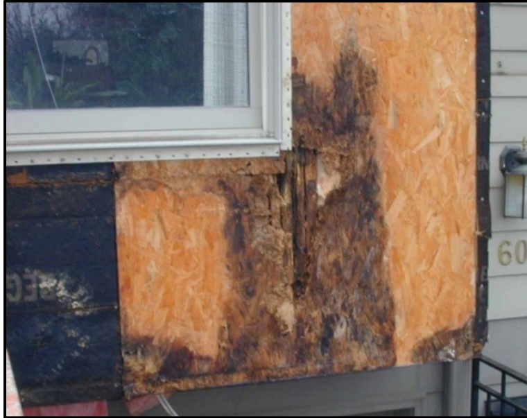
Figura 75 - Infiltração ocorrida entre a janela e o revestimento externo causando apodrecimento da chapa de OSB e montantes estruturais.
