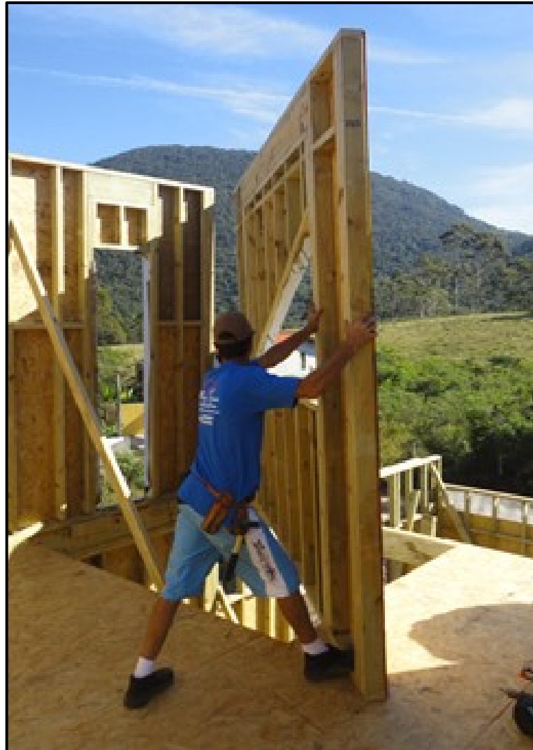
Figura 25 - Pannel semi-industrializado sendo montado no local.
