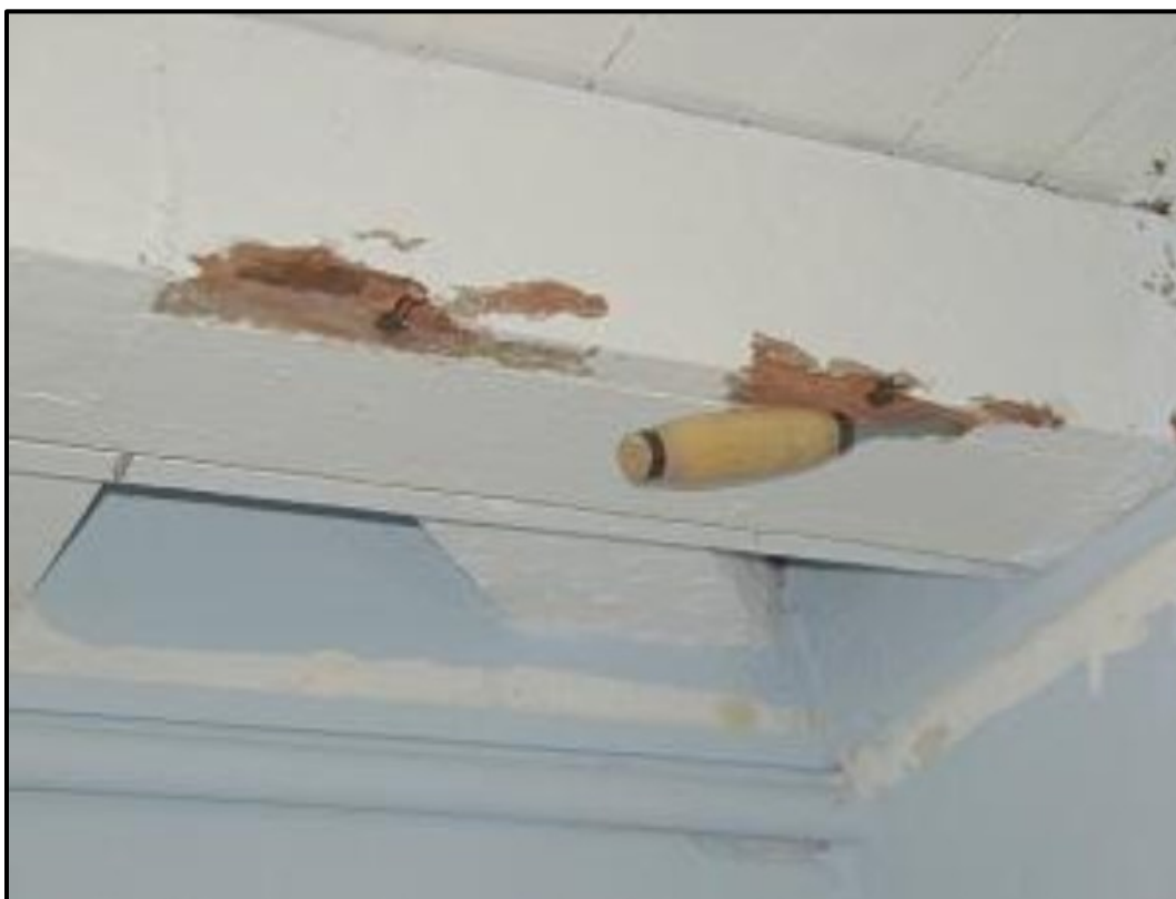
Figura 84 - Uso de formão para escarificação.
