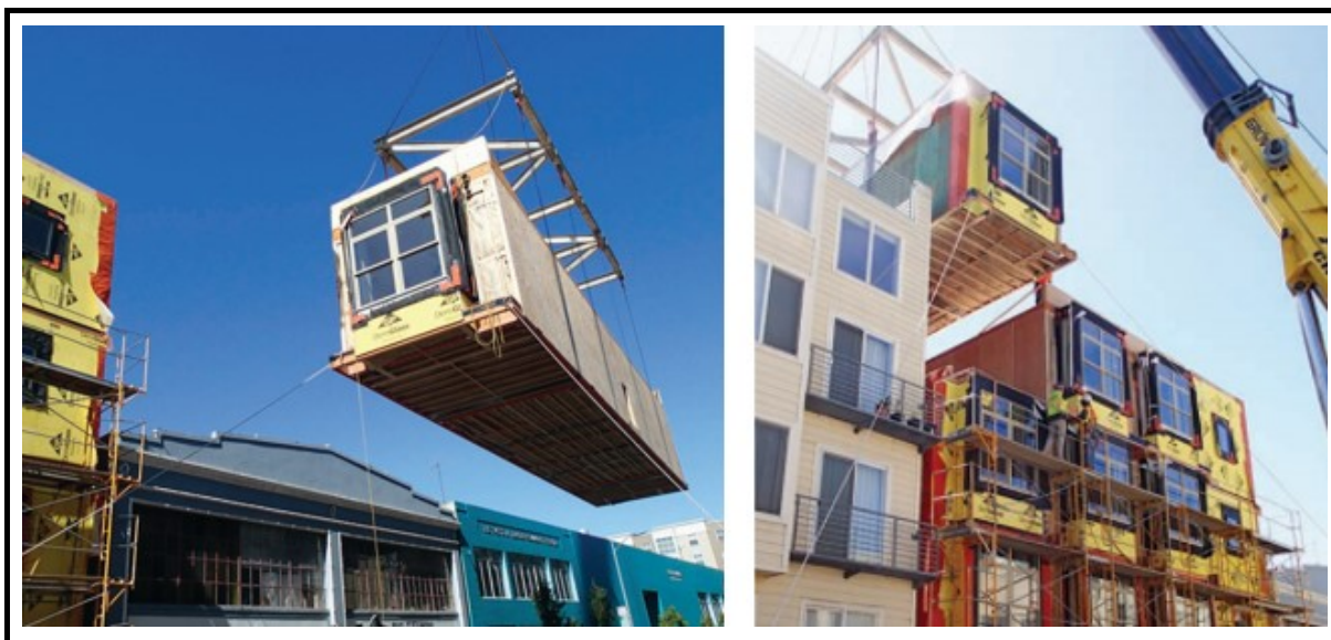
Figura 27 - Módulos de madeira sendo transportados e conectados.
