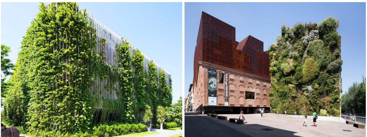
Figura 7: Fachada verde com trepadeiras em um hotel em Naman, Vietnã. Figura 8: Parede viva com diferentes espécies vegetais no Museu CaixaForum, em Madrid.
