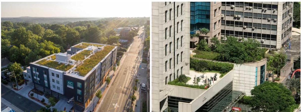
Figura 6: Telhado verde intensivo em uma agência bancária na cidade de São Paulo/SP.
