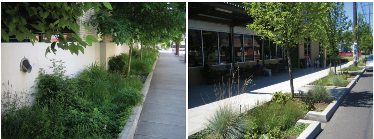
Figuras 11 e 12: Canteiros pluviais ao lado da garagem do Liberty Center e junto do New Seasons Market , em Portland, Estados Unidos.
