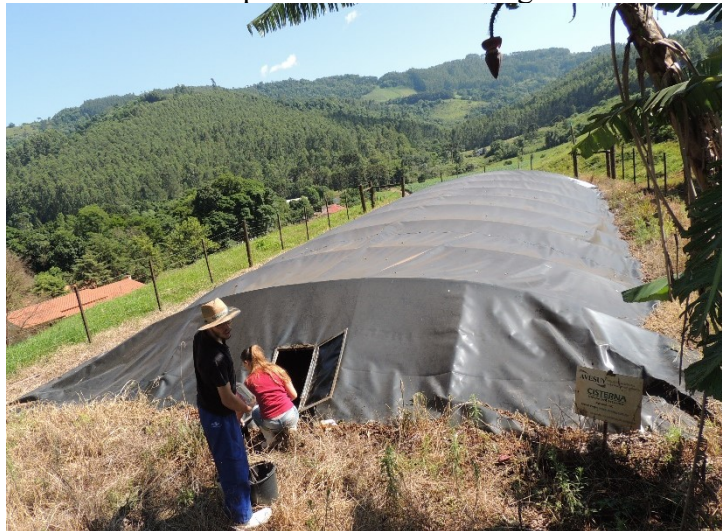
Figura 8. Cisterna do tipo semienterrada em geomembrana PEAD
