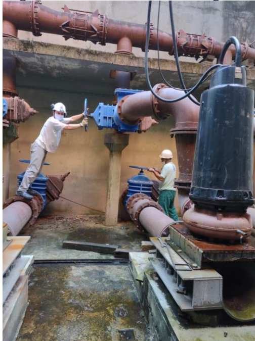
Figura 36 – Fechamento dos Registros
