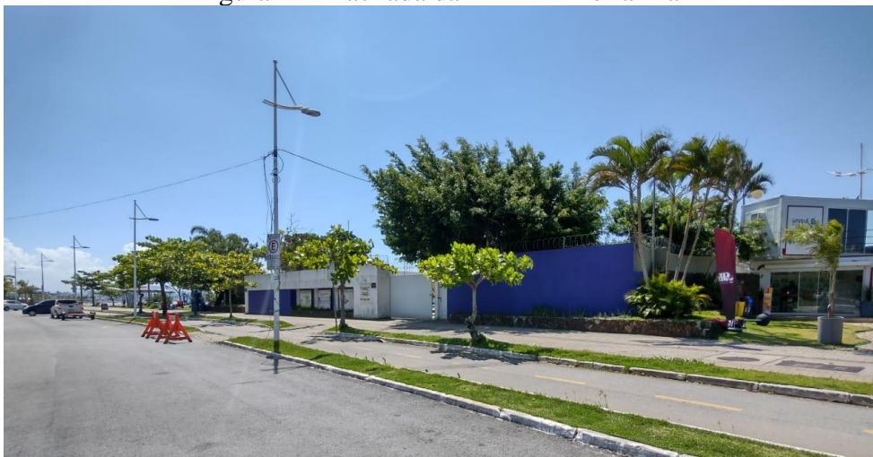
Figura 14 - Fachada da EEE A - Beira Mar
