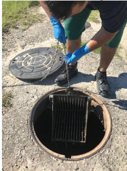
Figura 23- Colocação do Cesto após a limpeza
