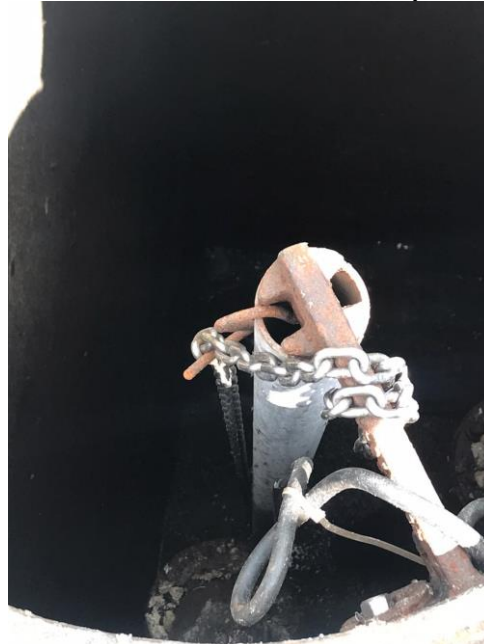
Figura 8 – Elevatória Convencional do tipo Poço Úmido
