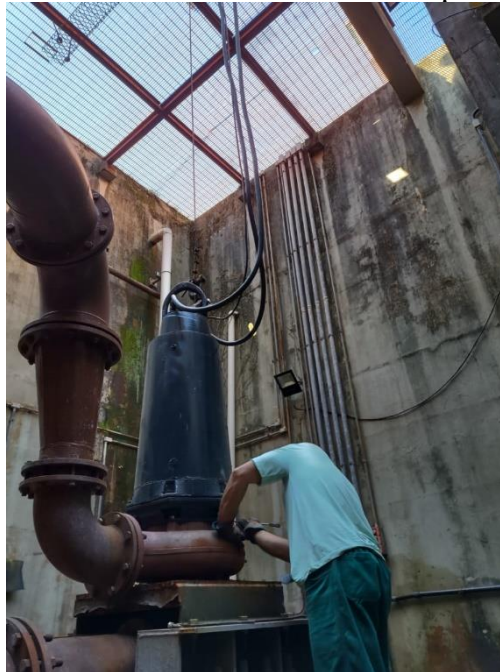
Figura 7 – Elevatórias convencionais do tipo Poço Seco
