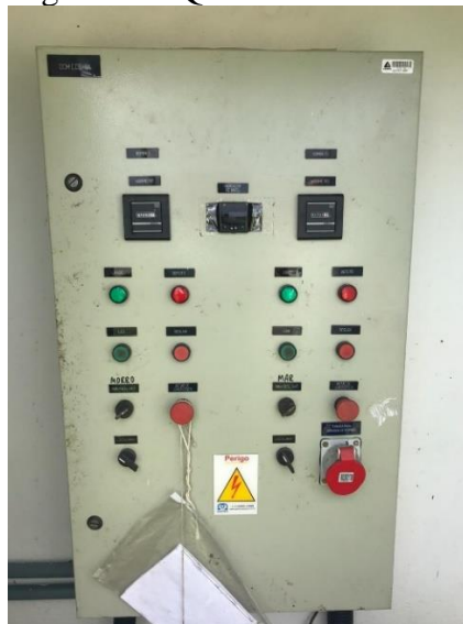
Figura 24 - Quadro de Comando
