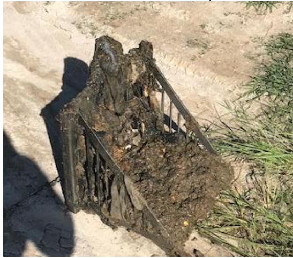
Figura 4 – Cesto Retentor de Materiais para Vazões Menores
