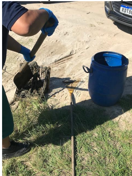
Figura 22 – Limpeza do cesto na superfície
