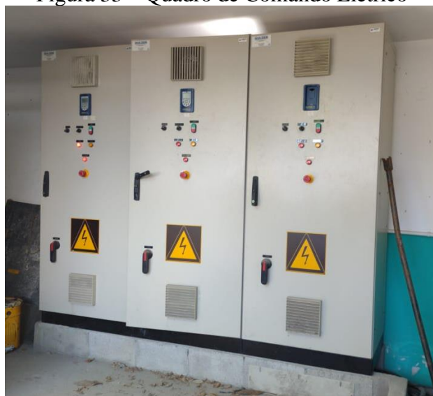
Figura 33 – Quadro de Comando Elétrico
