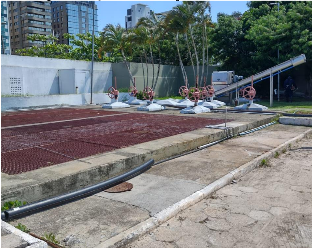
Figura 3 – Estação Elevatória de Esgoto – EEE A1 Beira Mar
