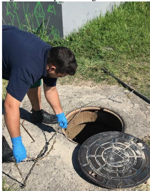
Figura 20 – Operador erguendo a bomba
