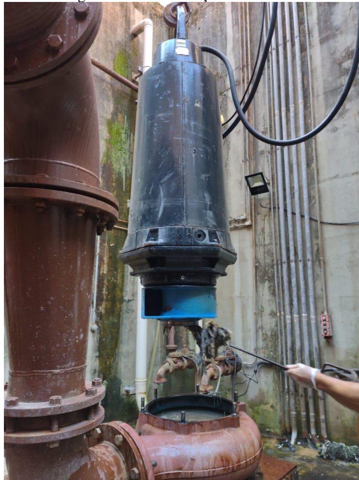
Figura 38 - Desobstrução da Bomba 2
