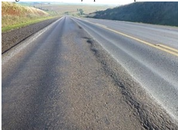
Figura 5.1 – Deformação permanente por fluência
