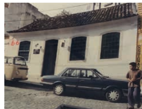
EDIFICAÇÃO 10 jun/93. Fonte: Norberto Depizolatti - acervo SEPHAN;
