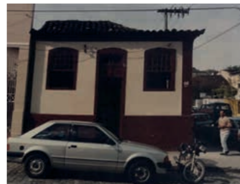
EDIFICAÇÃO 6 jun/93. Fonte: Norberto Depizolatti - acervo SEPHAN;
