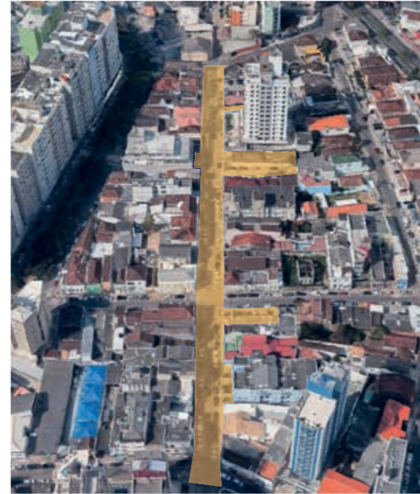
Imagem 11 - Vista superior com demarcação do TRECHO 02.
