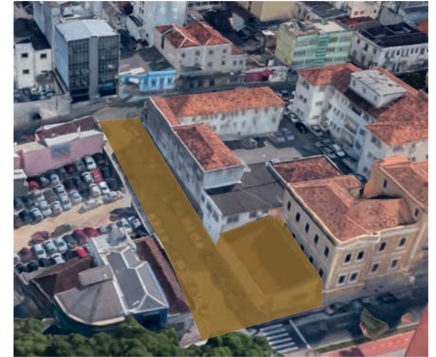
Imagem 19 - Vista superior com demarcação do TRECHO 04.
