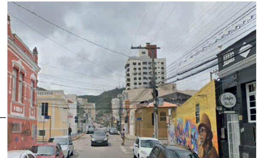
Imagem 13 - Edificações tombadas no cruzamento com R. Anita Garibaldi.
