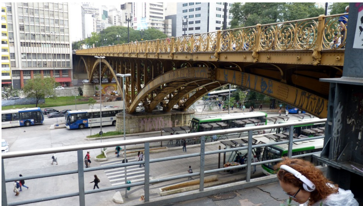
Viaduto Santa Ifigênia / Anhangabaú, 2017
