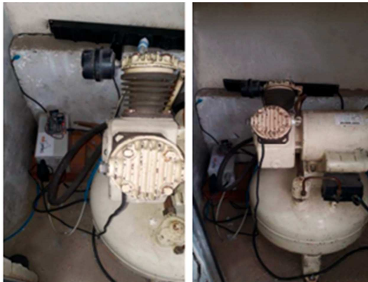
Figura 28 – Local de instalação do módulo de aquisição de dados na unidade de saúde.
