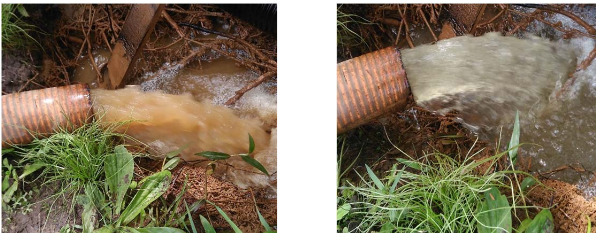
Figura 107 - Realização do expurgo no poço de produção, antes (à esquerda) e depois (à direita) do procedimento
