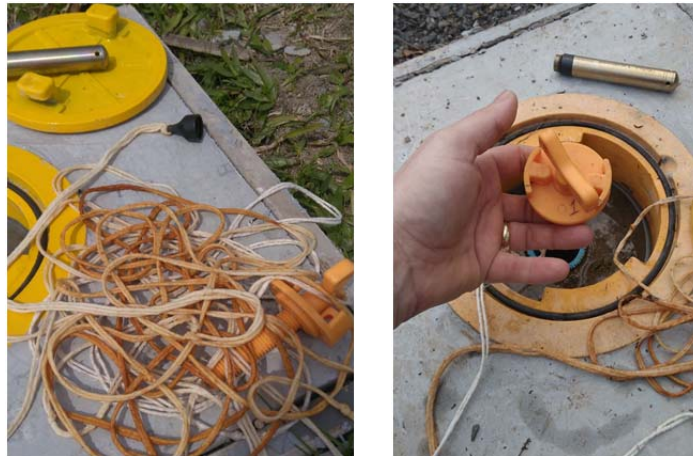
Figura 72 - Instalação dos medidores de nível eletrônico no piezômetro
