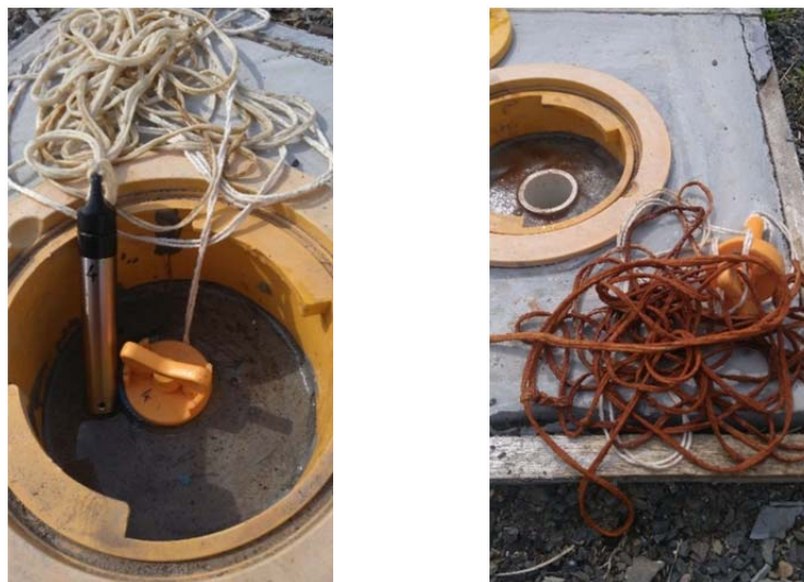
Figura 91 - Encrustamento com ferro oxidado (ferrugem) no medidor – início (à esquerda) e após meses de medição (à direita)
