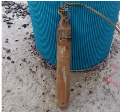
Figura 106 - Encrustação de ferro oxidado (ferrugem) no medidor de nível eletrônico no poço
