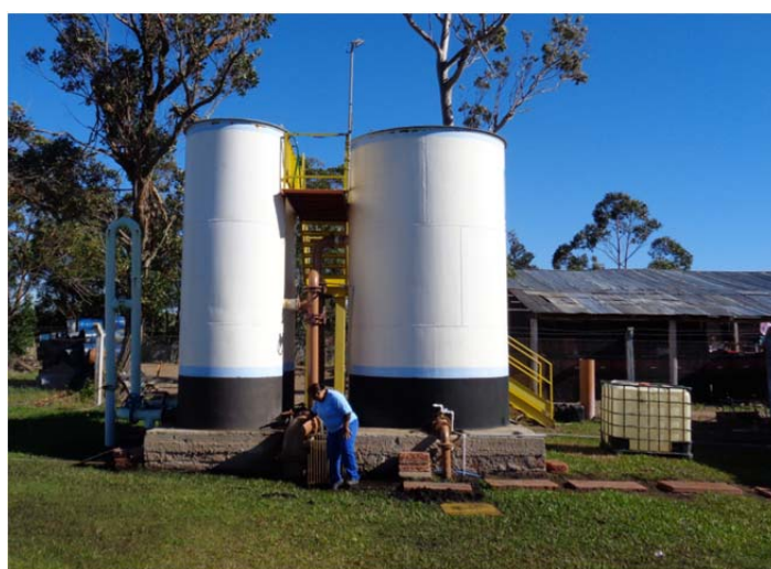
Figura 109 - Imagem dos filtros (2, à esquerda) e do floco-decantador (1, à direita)
