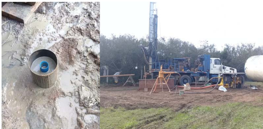
Figura 68 - Perfuração do poço de produção, à direita e imagem de um piezômetro (à esquerda)
