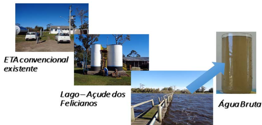
Figura 65 - ETA Granja Vargas, Palmares do Sul, estado do Rio Grande do Sul - Corsan
