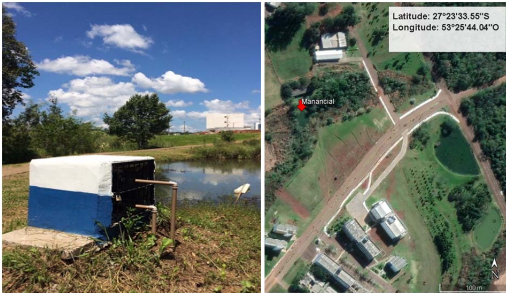
Figura 25 - Casa de bombas e manancial de abastecimento do sistema piloto, em escala laboratorial
