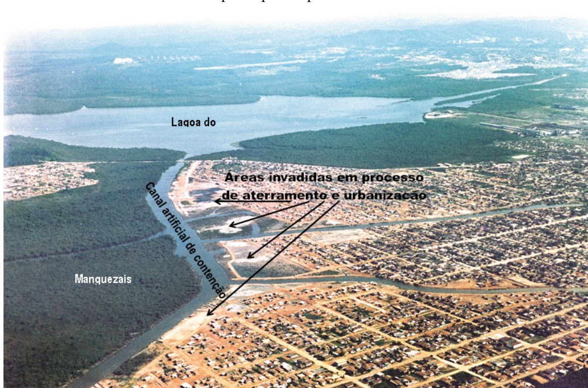
Figura 18 – Fase de implantação do Projeto Mangue com as indicações das áreas aterradas e ocupadas pela expansão urbana.
