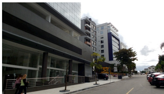
Fig. 284 – Rua Patrício Farias
