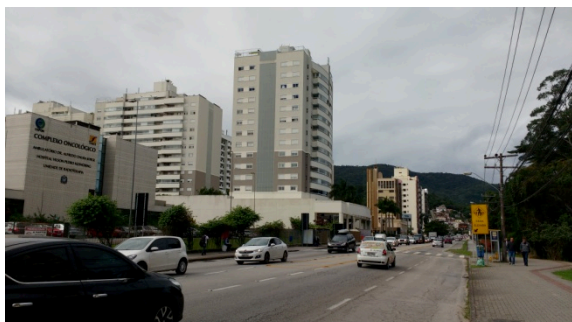
Fig. 285 – Rodovia Ademar Gonzaga
