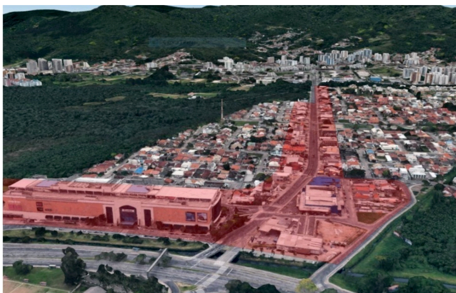
Fig. 287 - Vista geral do “Centro de Bairro Santa Mônica” - Em vermelho o recorte AMC analisado
