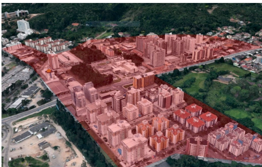
Fig. 275 - Vista geral do “Centro de Bairro Itacorubi” - Em vermelho o recorte AMC analisado
