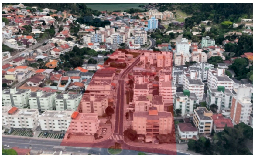
Fig. 227 - Vista geral do “Centro de Bairro Carvoeira” - Em vermelho o recorte AMC analisado
