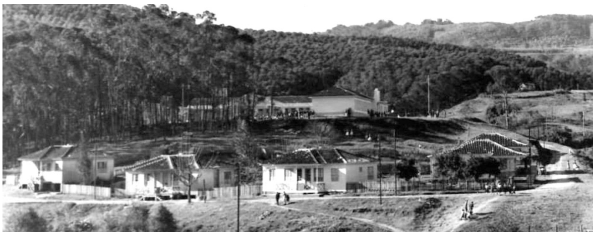
Figura 41 - Casas geminadas com varandas construídas, inicialmente, para os funcionários do SENAI; em segundo plano, a sede do SENAI.
