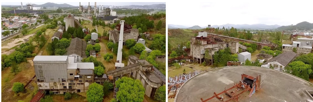
Figura 97 - As ruínas do Lavador de Capivari como um friche industrial na paisagem cultural
