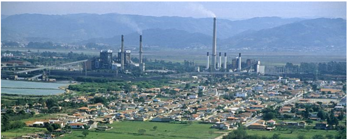
Figura 34 - Vista de Capivari de Baixo, com destaque para o Complexo Termelétrico Jorge Lacerda
