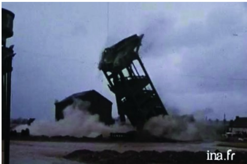
Figura 6 - Demolição do último chevalement de Hérin , 1978
