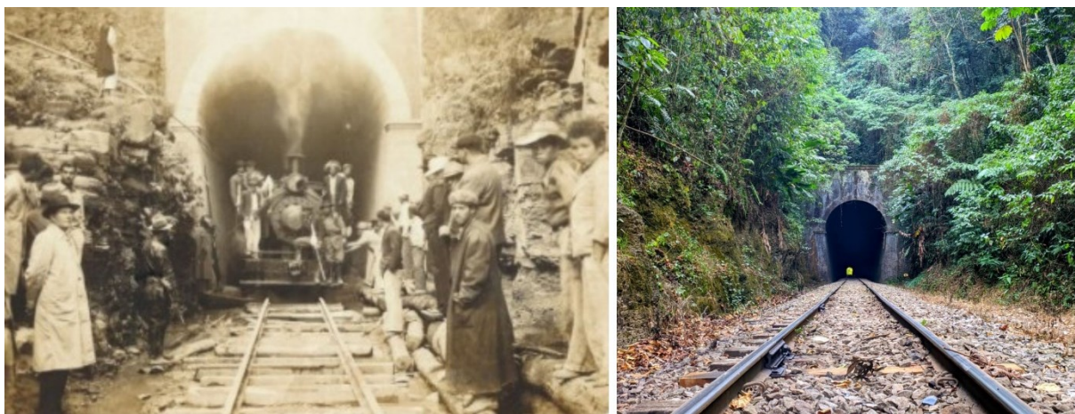
Figura 44 - Túnel ferroviário em Siderópolis
