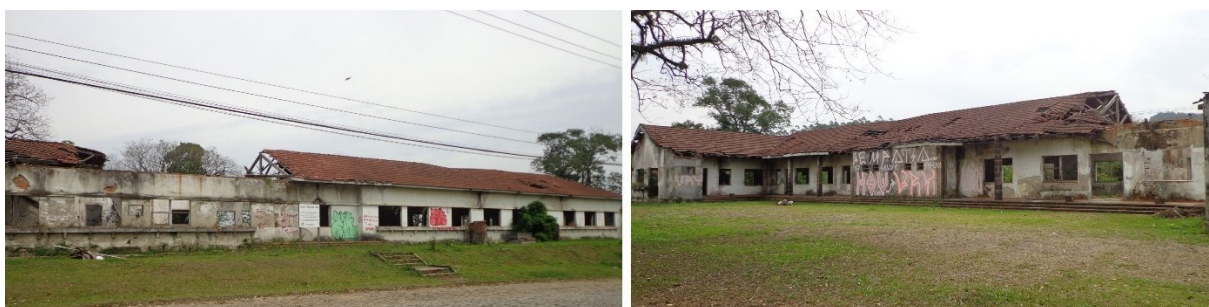
Figura 77 - Atual estado de conservação do “escritório”, antiga sede administrativa da CSN em Rio Fiorita.
