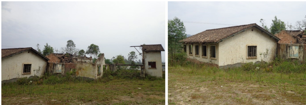
Figura 65 - Ruínas do antigo Recreio do Trabalhador, em Rio Fiorita
