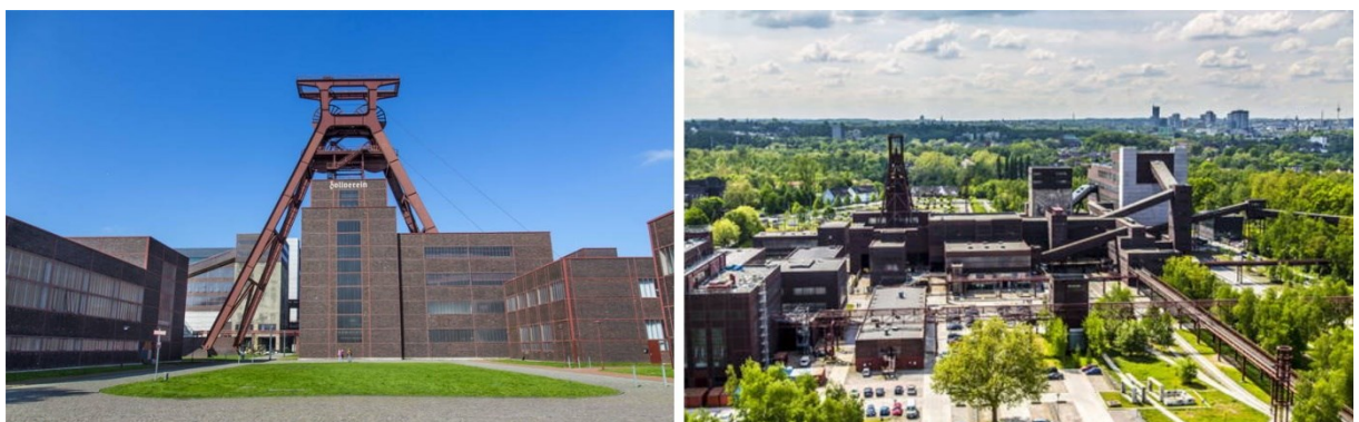
Figura 15 - Vista aérea do complexo de Zollverein
