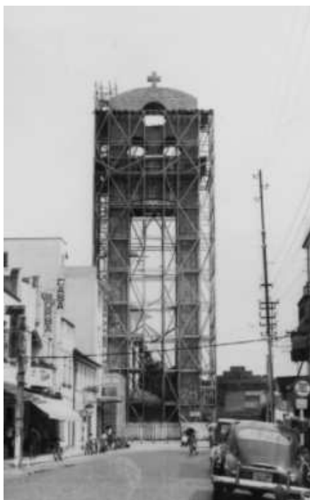
Figura 19 – Construção da torre sineira da Igreja Matriz São Paulo Apóstolo. Blumenau. Começo da década de 1960.
