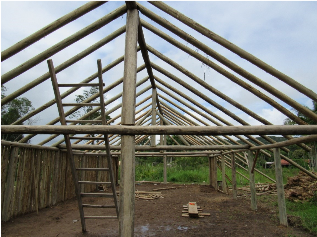
Figura 24- Opy em construção- Tekoa Itanhaém. Foto do autor, 2018.
