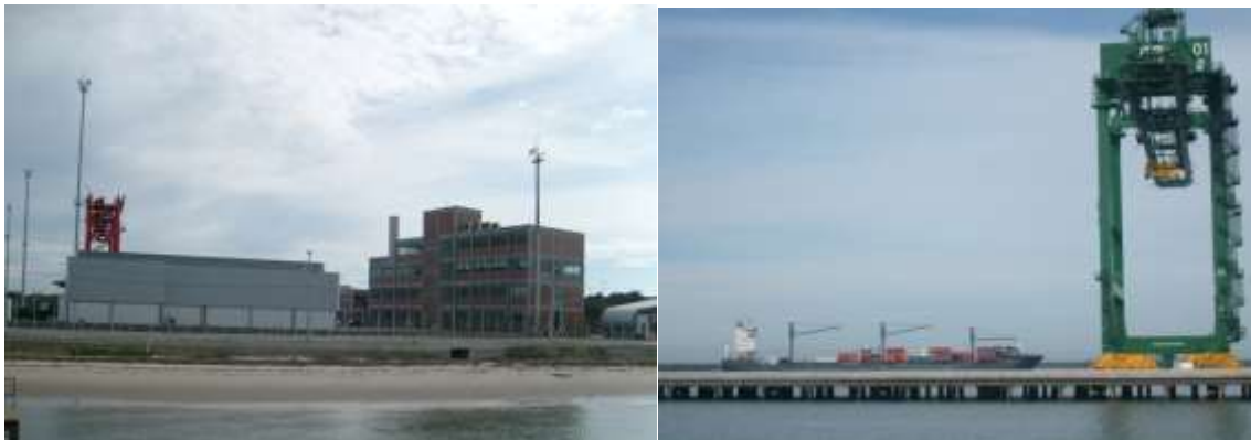
Figura 17: Terminal Privado de Itapoá-SC em construção.
