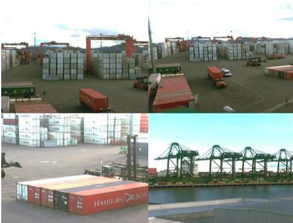
Figura 18: Terminal Portuário de Itapoá – SC, em operação.
