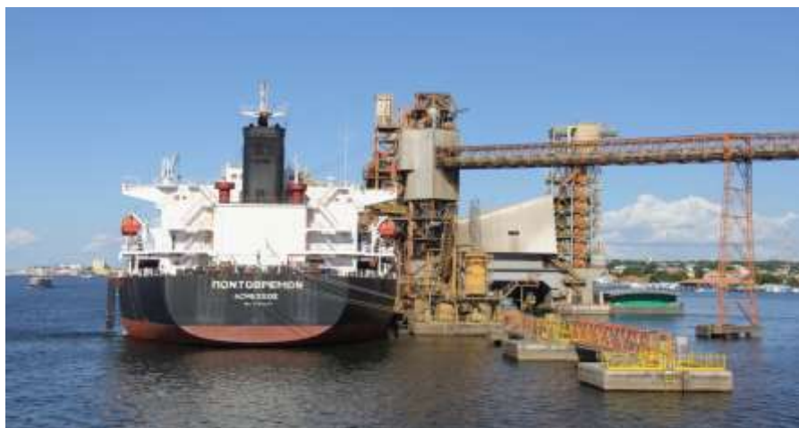
Figura 12: Terminal portuário de Santarém-PA, carregamento de grãos automatizados.
