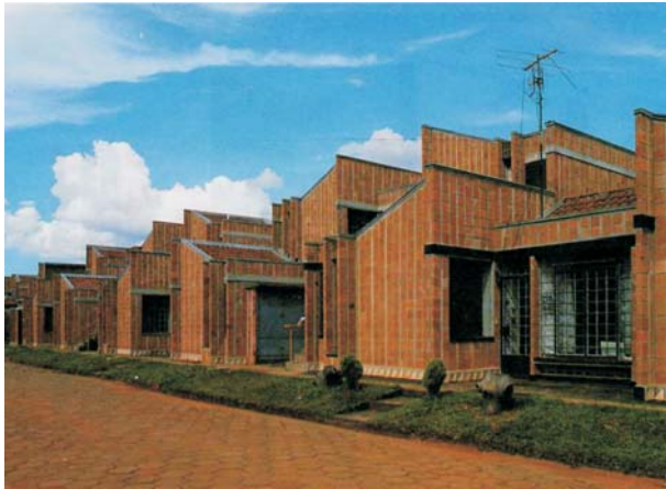
Vista geral do conjunto. Moradia Estudantil da Unicamp.
