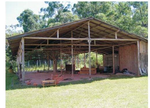
Antigo galpão de obra. Funciona indevidamente como área de lazer. Fonte: acervo próprio
