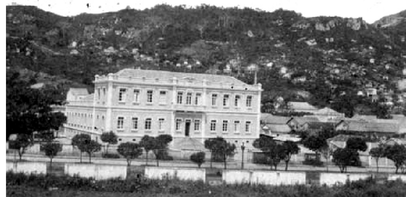
Figura - Maternidade Carlos Correa - Entrada do Asilo pela Av. Hercílio Luz Fonte: Imagens de um presente
